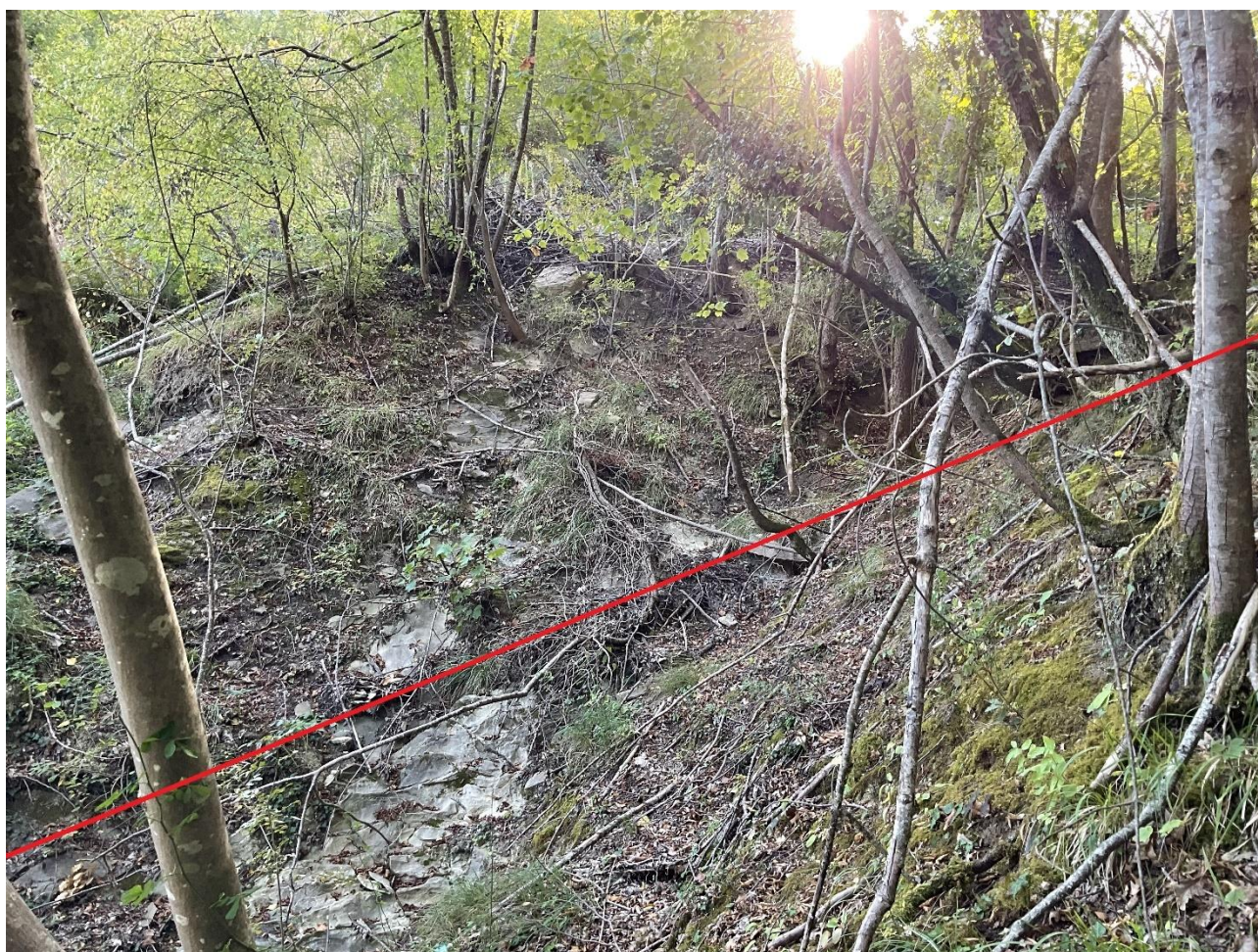
Figura 5.3/C. Documentazione fotografica del tratto di attraversamento.
