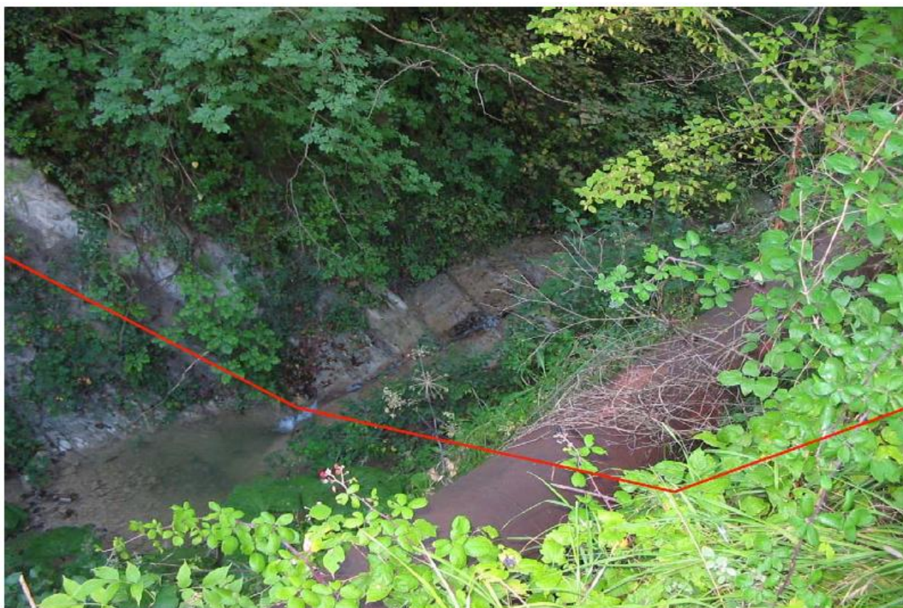
Figura 5.4/C. Documentazione fotografica del tratto di attraversamento.
