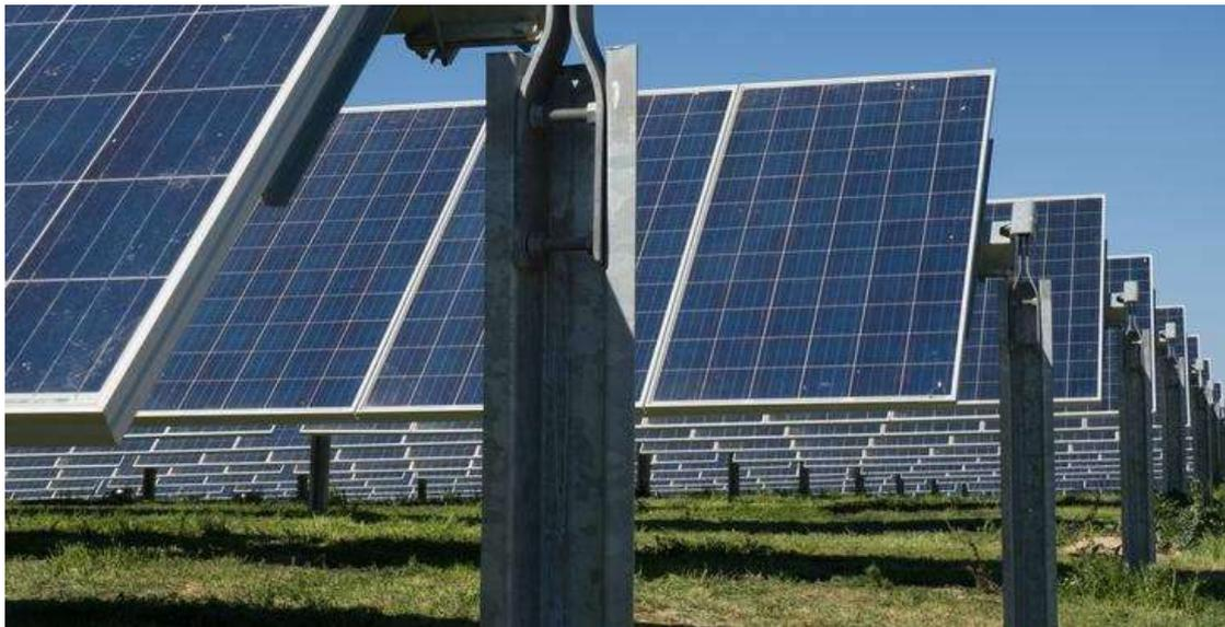
*Figura 3-7 - Immagine esplicativa dell'allestimento dei pannelli sulla struttura tracker*
