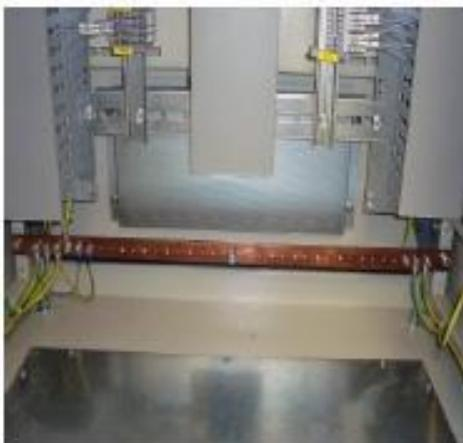
[Fig. 3.7.3.3] – Particolare della barra di terra
