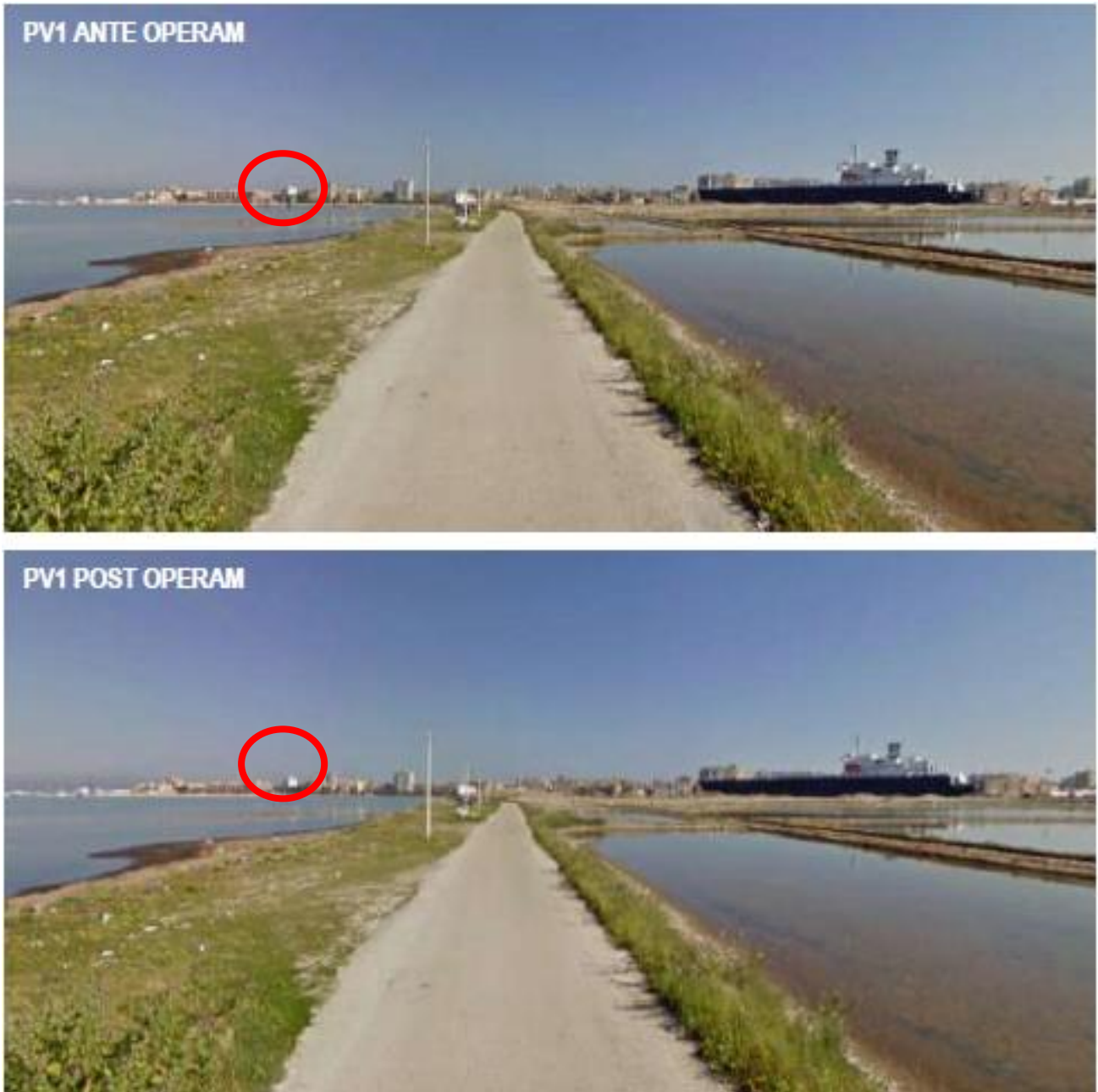
Figura 4: Confronto ante e post lavori di salpamento ex diga
