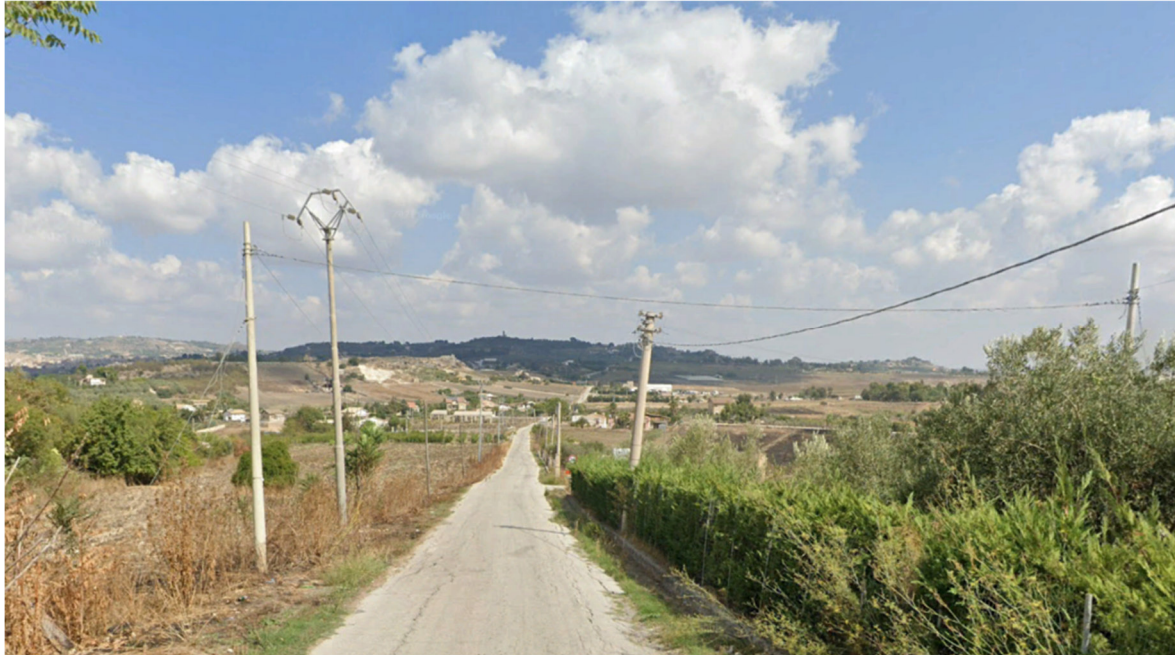
Interferenza 7 Attraversamento linea elettrica Strada senza nome, Comune di Canicattì, e-distribuzione
