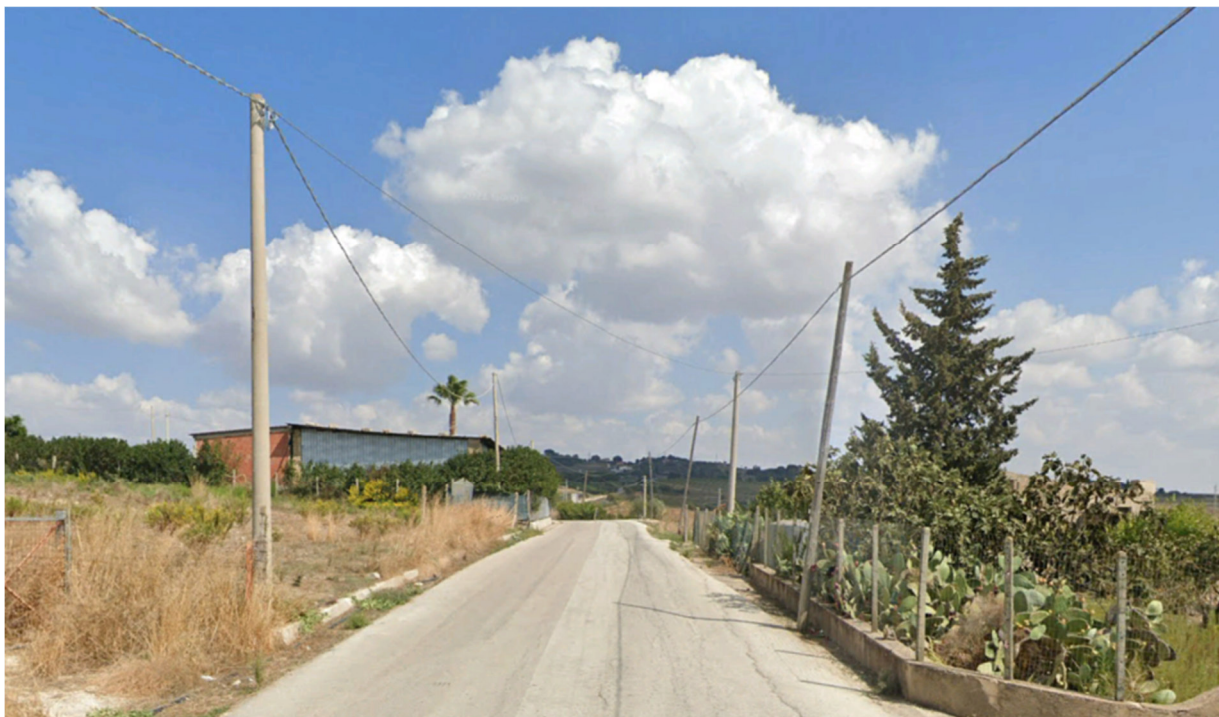
Interferenza 14 Attraversamento linea elettrica SP48, e-distribuzione
