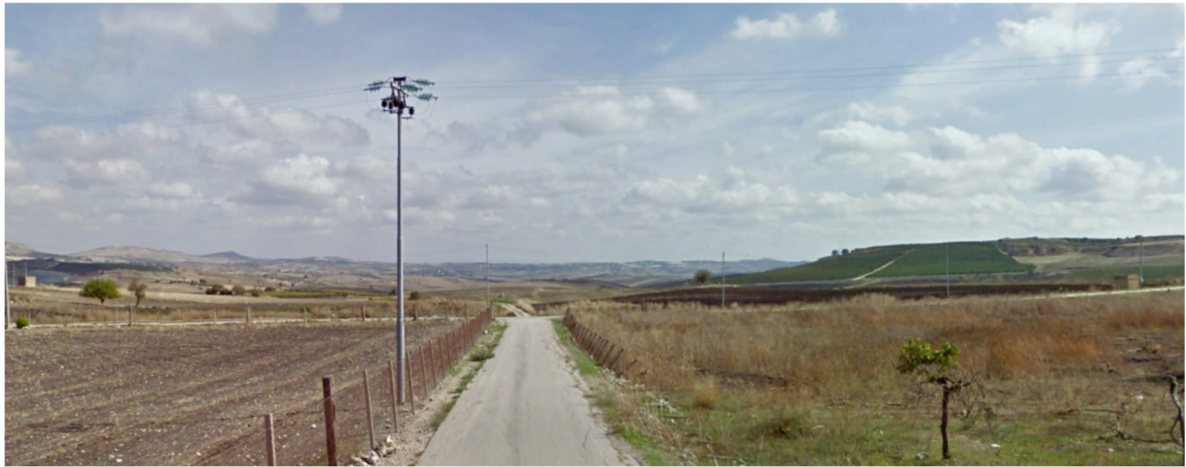
Interferenza 31 Attraversamento linea elettrica strada vic. Carbuscia Cataliello, Comune di Naro, e-distribuzione
