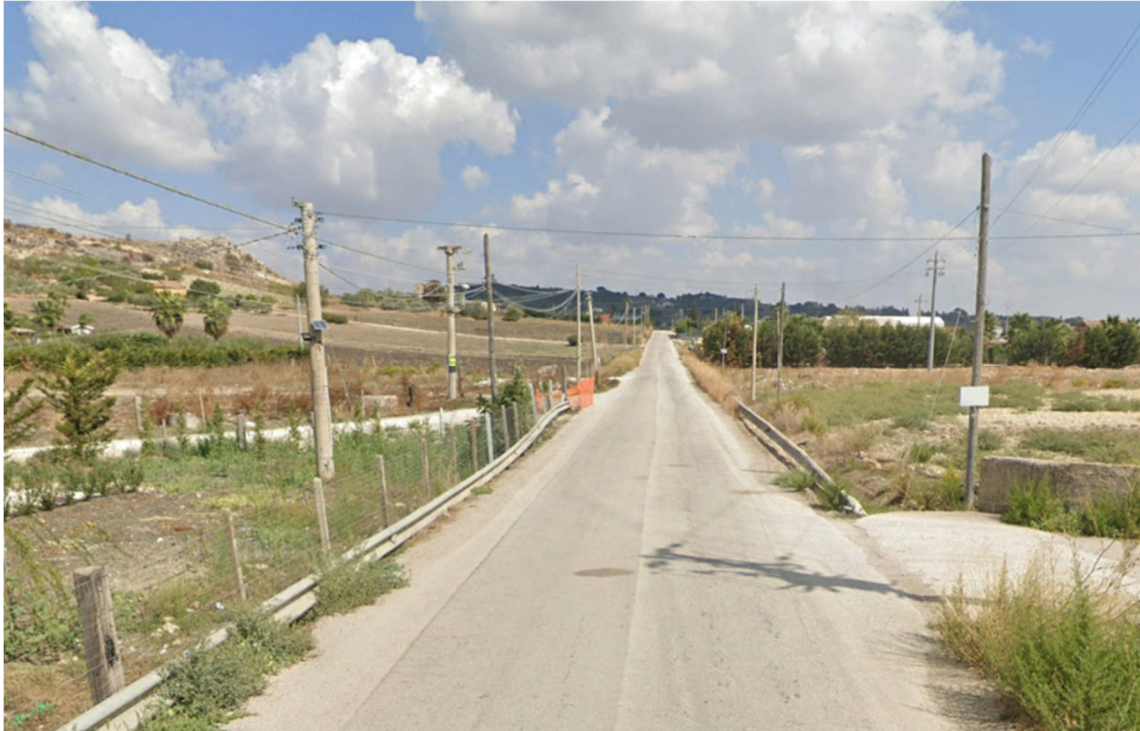
Interferenza 11 Attraversamento linea elettrica SP48, e-distribuzione
