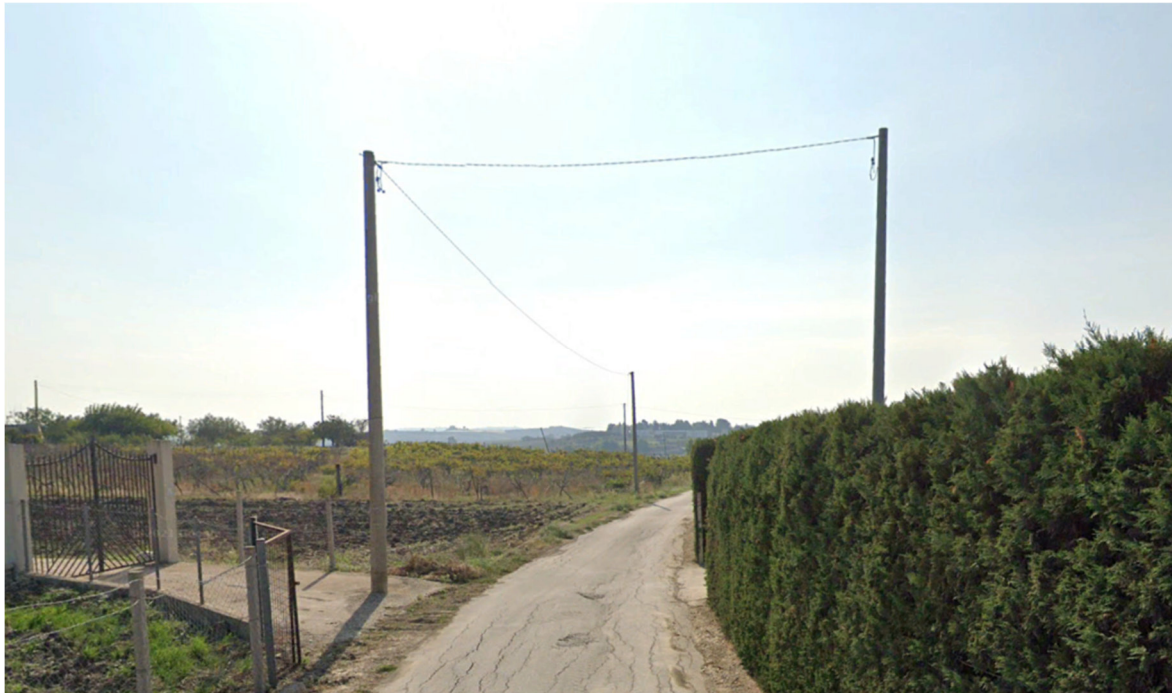
Interferenza 25 Attraversamento linea elettrica Strada senza nome, Comune di Naro, e-distribuzione
