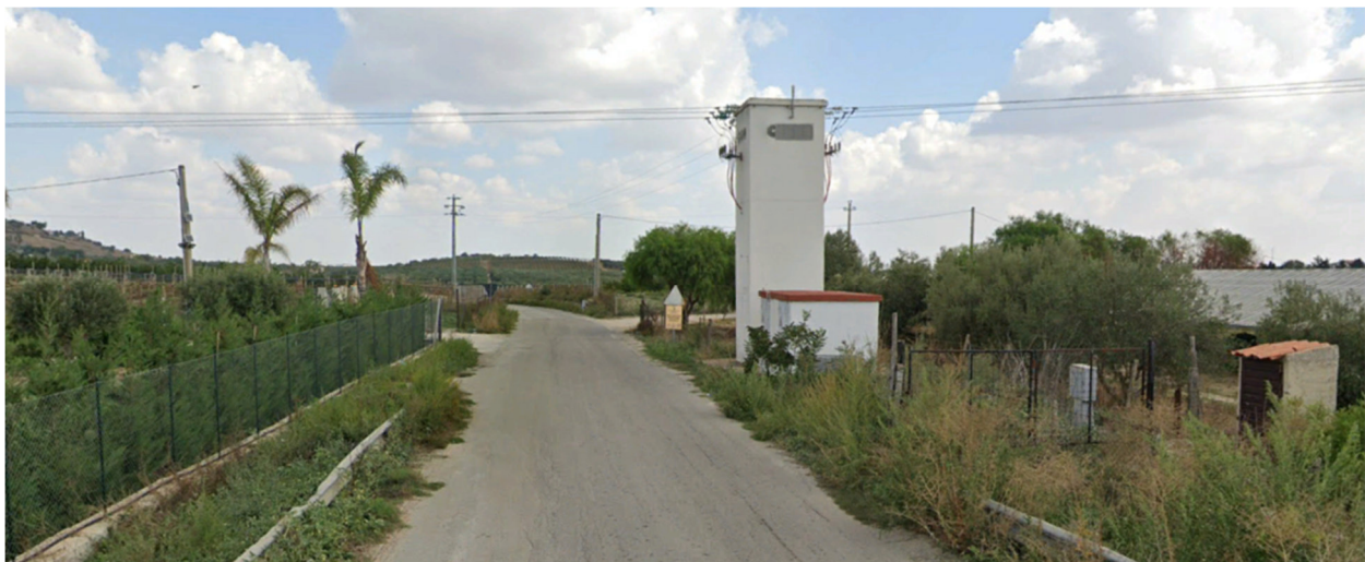
Interferenza 23 Attraversamento linea elettrica SP46C, e-distribuzione
