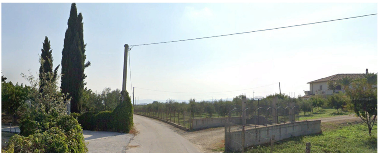
Interferenza 24 Attraversamento linea elettrica Strada senza nome, Comune di Naro, e-distribuzione
