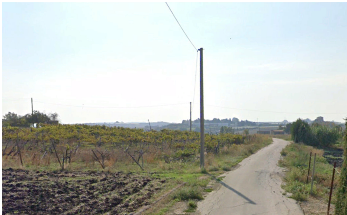
Interferenza 26 Attraversamento linea elettrica SP49, Comune di Naro, e-distribuzione
