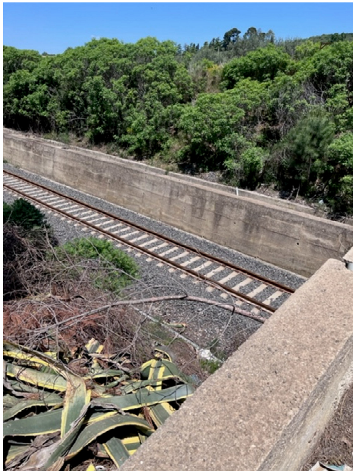
Interferenza 20 Attraversamento ferroviario sottostante SP 48, RFI
