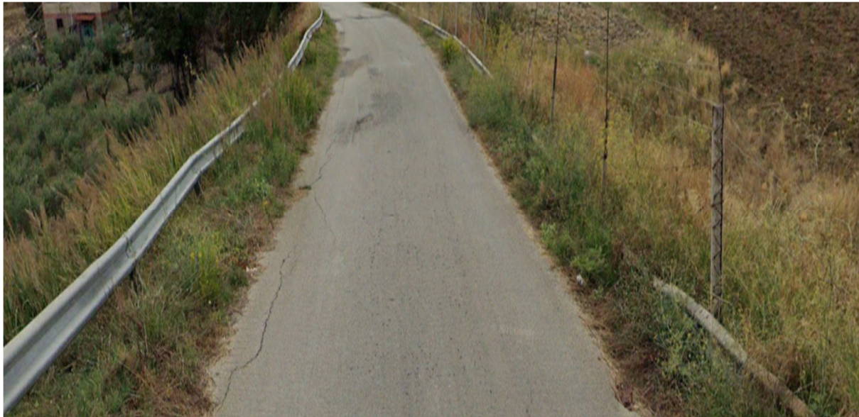
Interferenza 27 Attraversamento canale di scolo SP49, Comune di Naro, e-distribuzione
