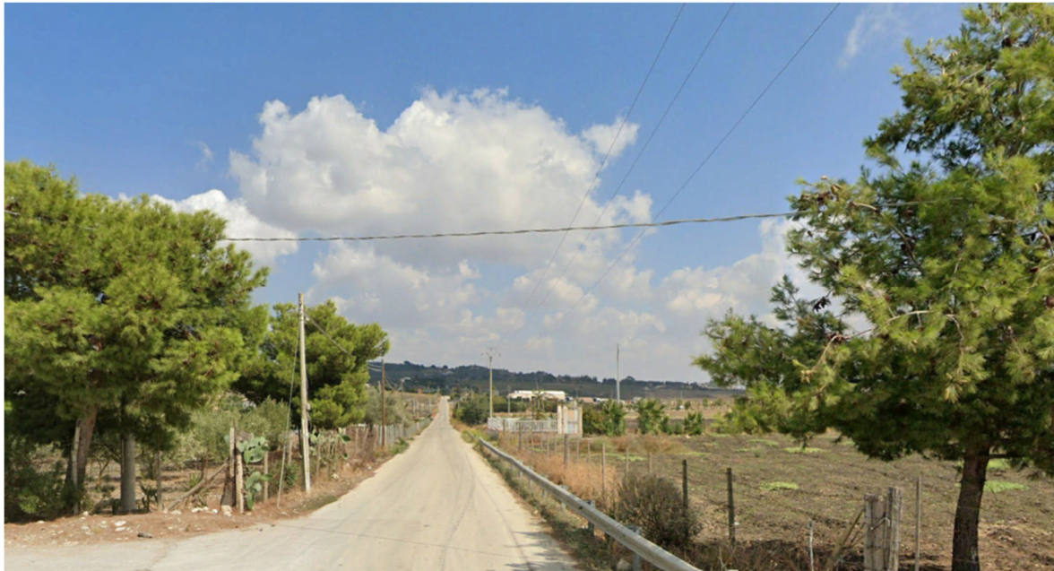
Interferenza 9 Attraversamento linea elettrica SP48, e-distribuzione
