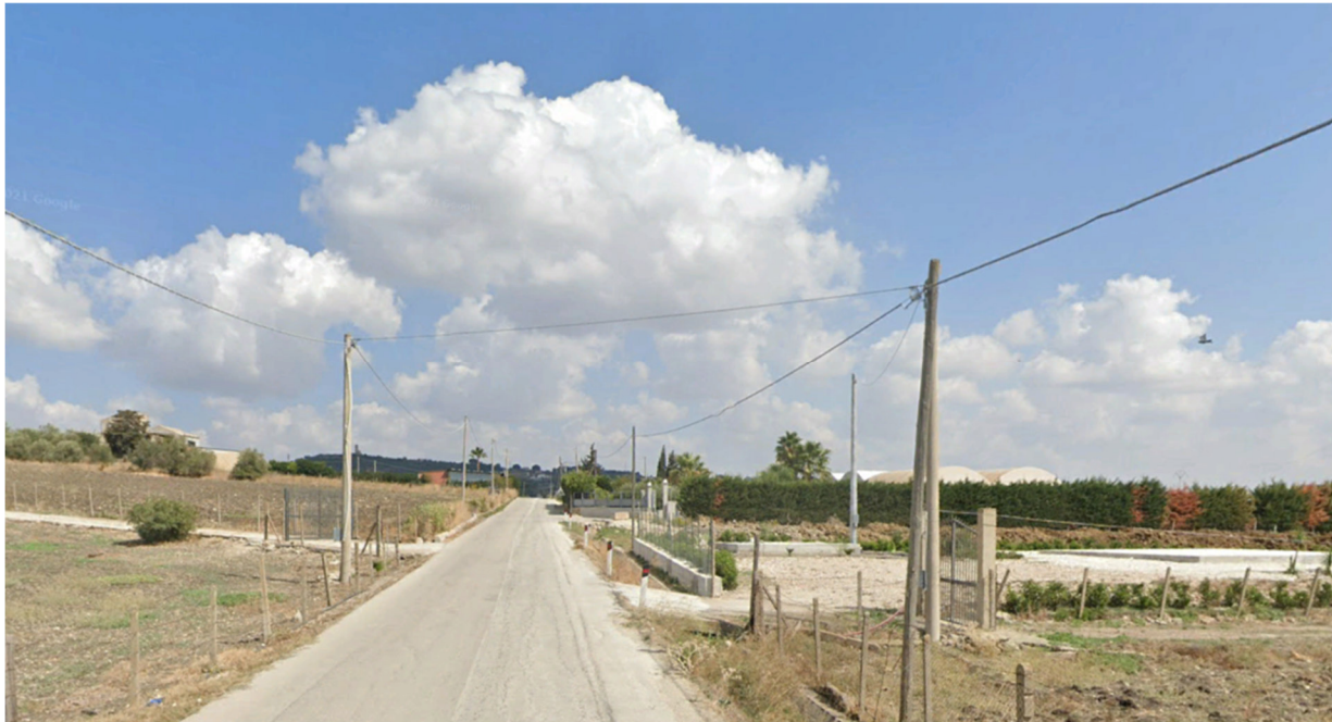
Interferenza 13 Attraversamento linea elettrica SP48, e-distribuzione
