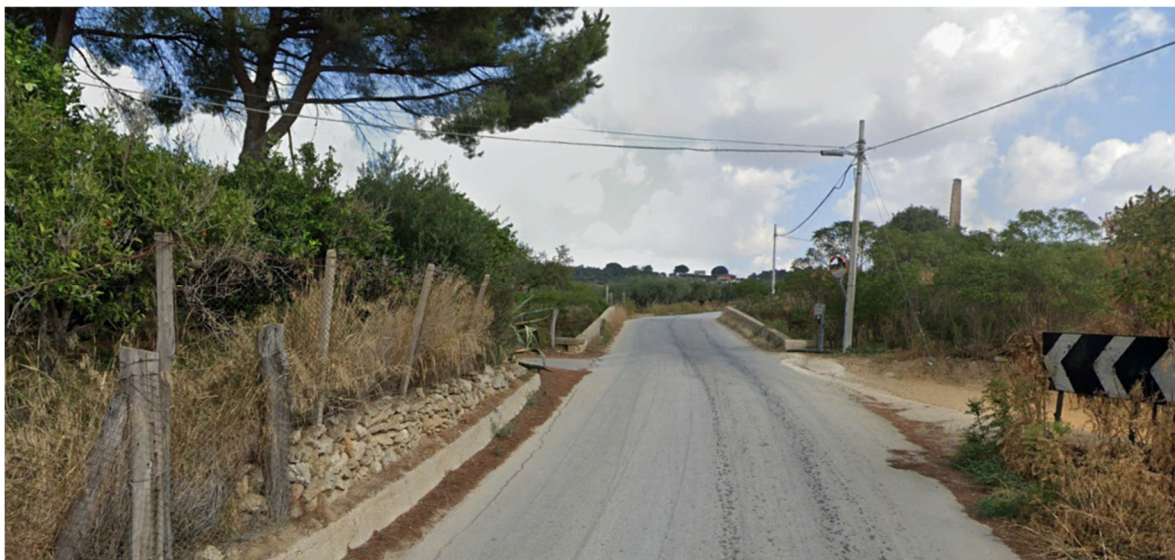
Interferenza 19 Attraversamento linea elettrica SP48, e-distribuzione
