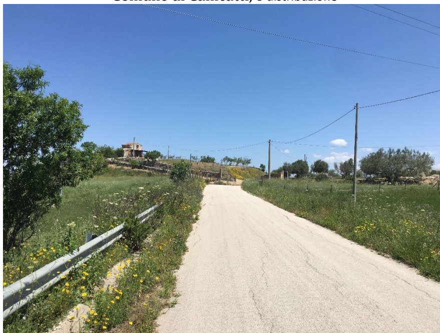
Interferenza 2 Attraversamento linea elettrica Strada senza nome, Comune di Canicattì, e-distribuzione
