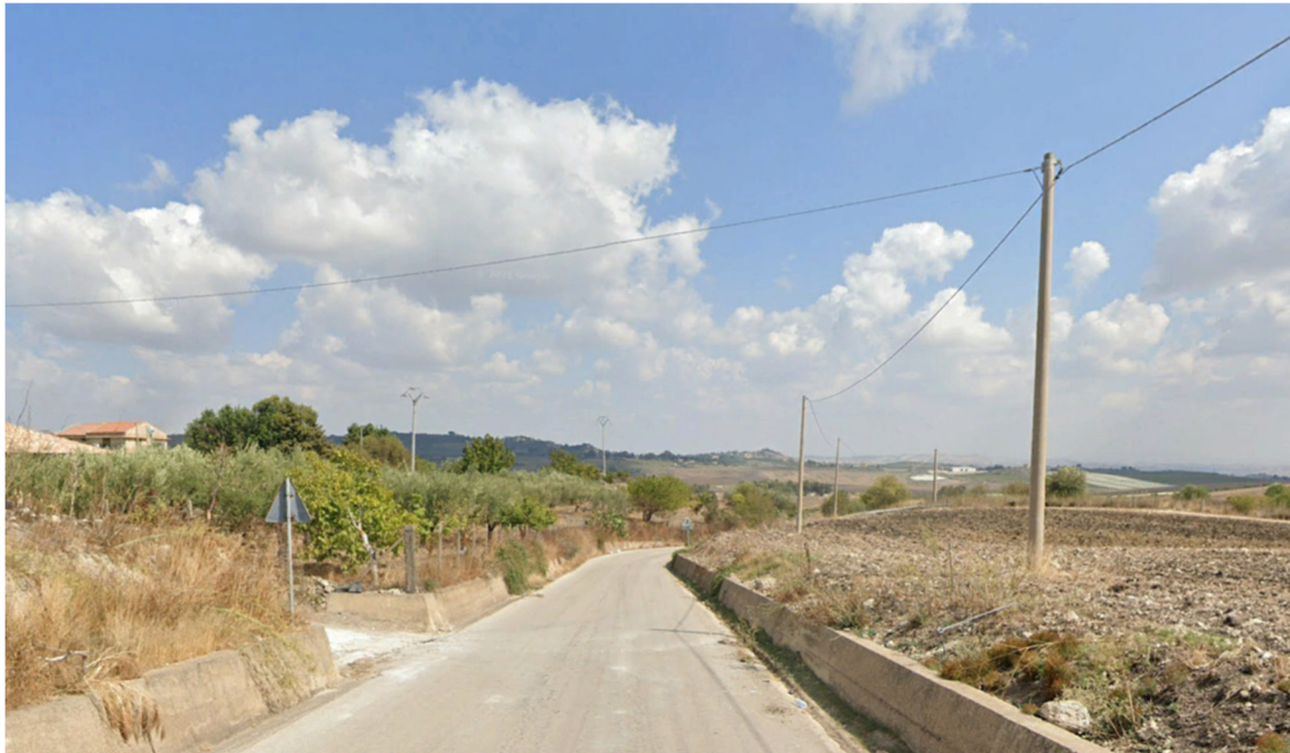
Interferenza 5 Attraversamento linea elettrica Strada senza nome, Comune di Canicattì, e-distribuzione
