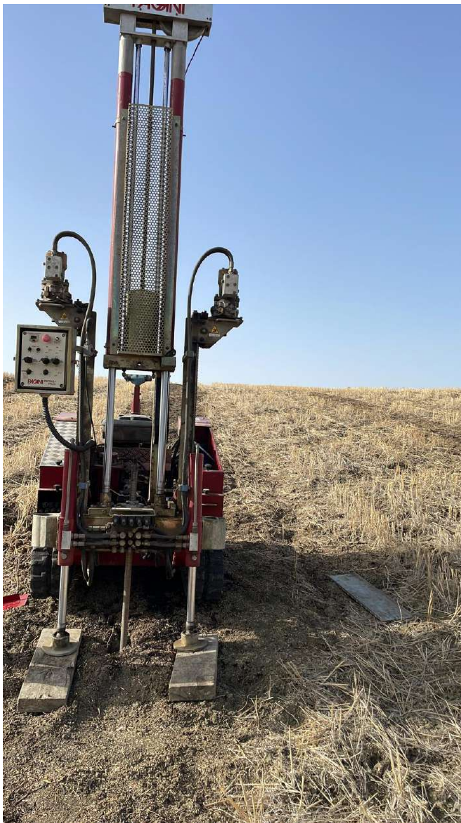
Prova DPSH 4 eseguita in situ
