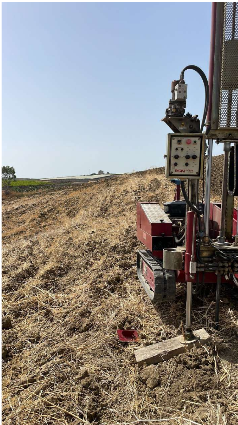
Prova DPSH 3 eseguita in situ
