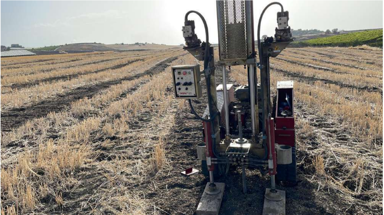
Prova DPSH 9 eseguita in situ
