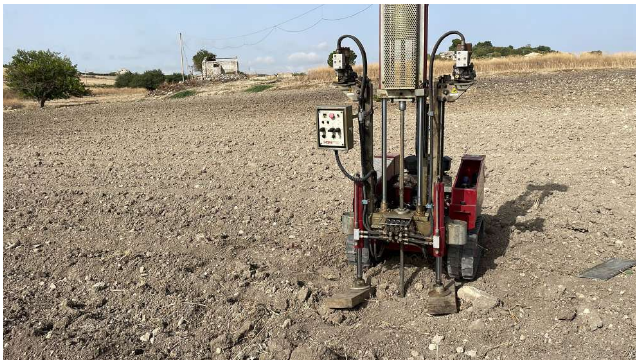
Prova DPSH 6 eseguita in situ
