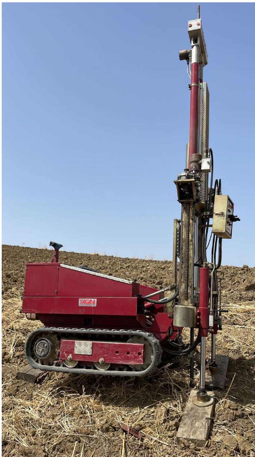
Prova DPSH 8 eseguita in situ
