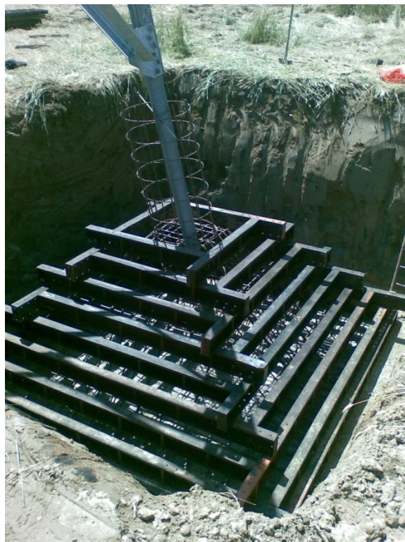
Figura 3.11.1.3-2 - Esempio di realizzazione del piede di fondazione
