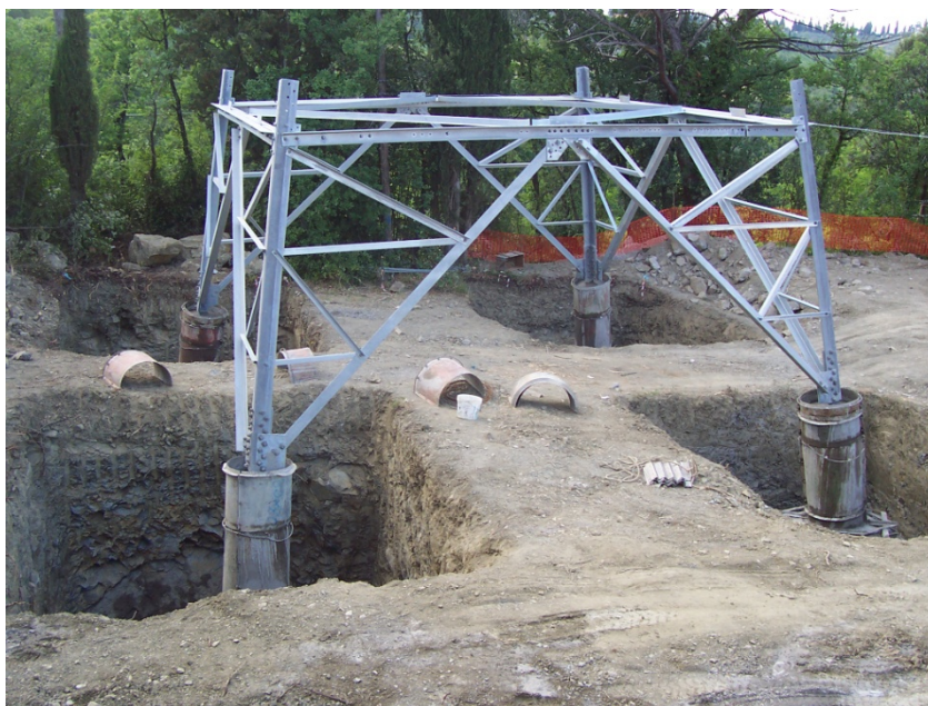
Figura 3.11.1.3-1 - Esempio di fondazione di un sostegno
