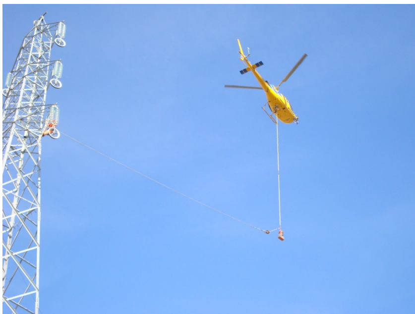
Figura 3.11.1.5-1 Esempio di l'utilizzo dell'elicottero per la stesura della corda pilota
