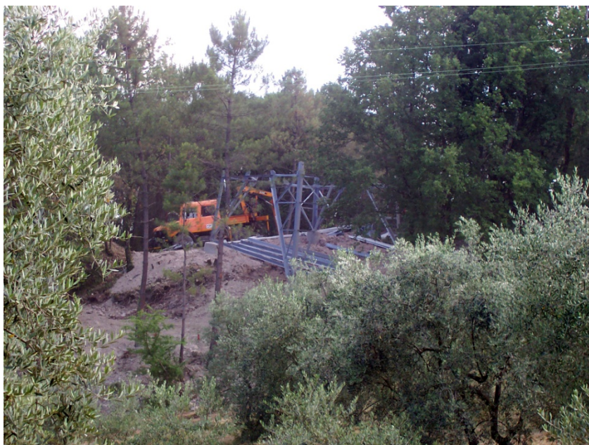
Figura 3.11.1.3-3 - Esempio di area di microcantiere
