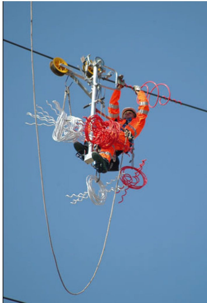
Figura 4.6.4-4.6.42 - Montaggio di dissuasori visivi
