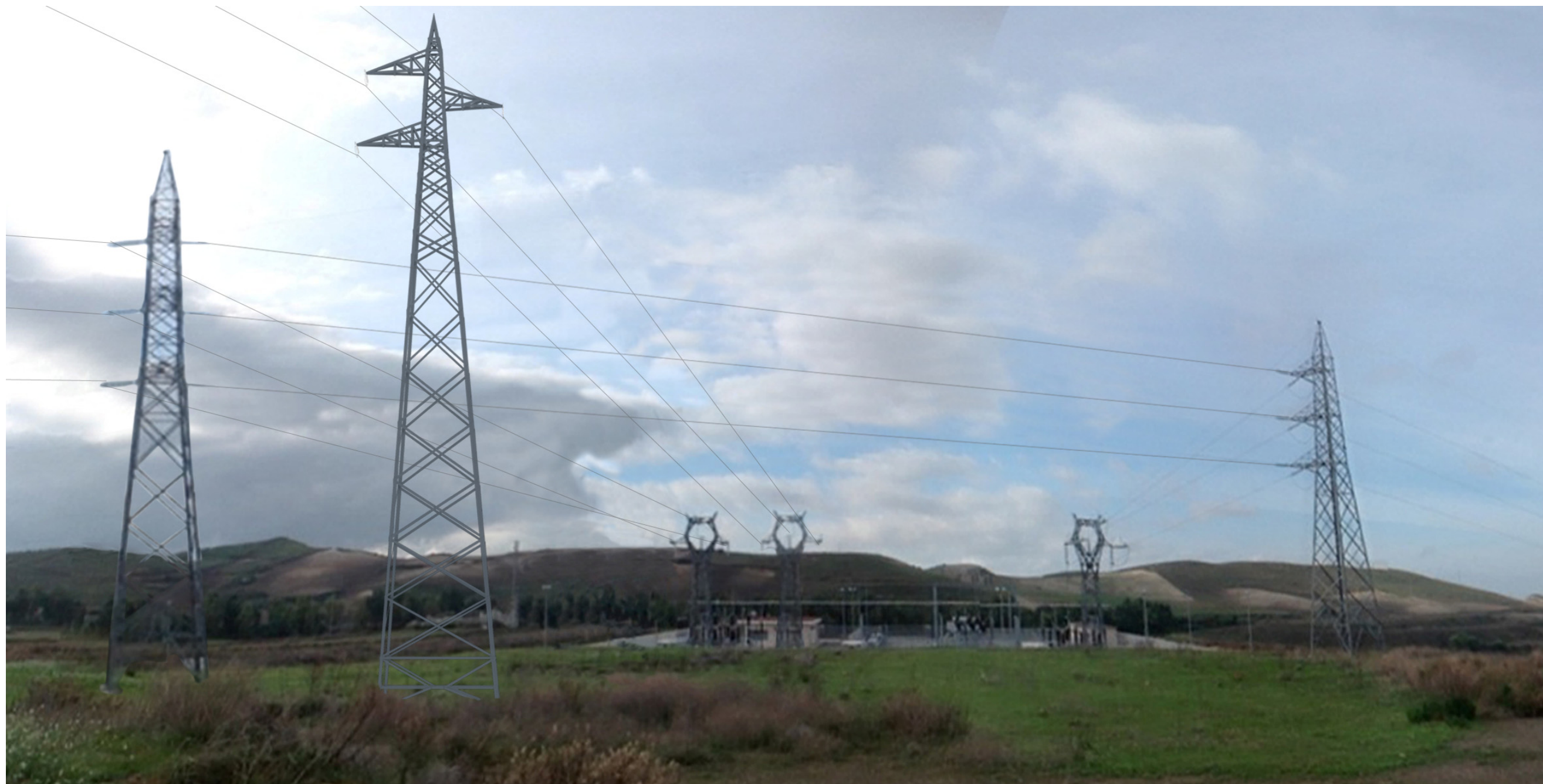
Figura 6.5-4 - Punto di Vista 1 Post operam
