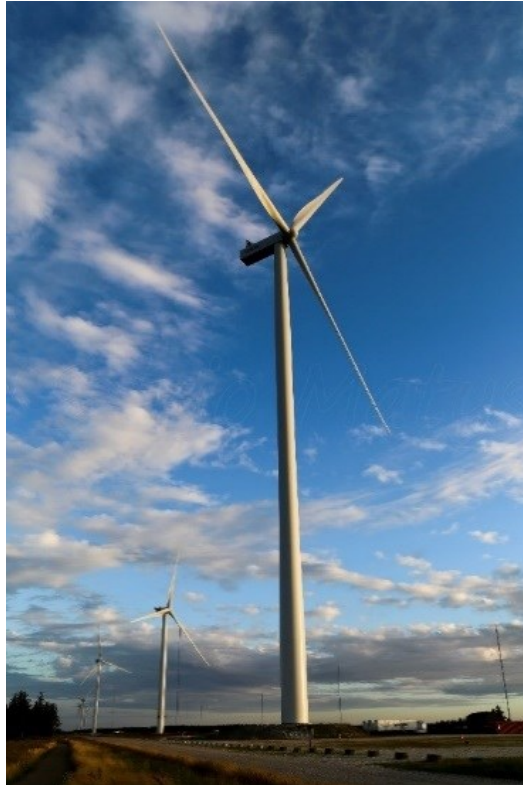
Figura 7 – Aerogeneratore Vestas V150
