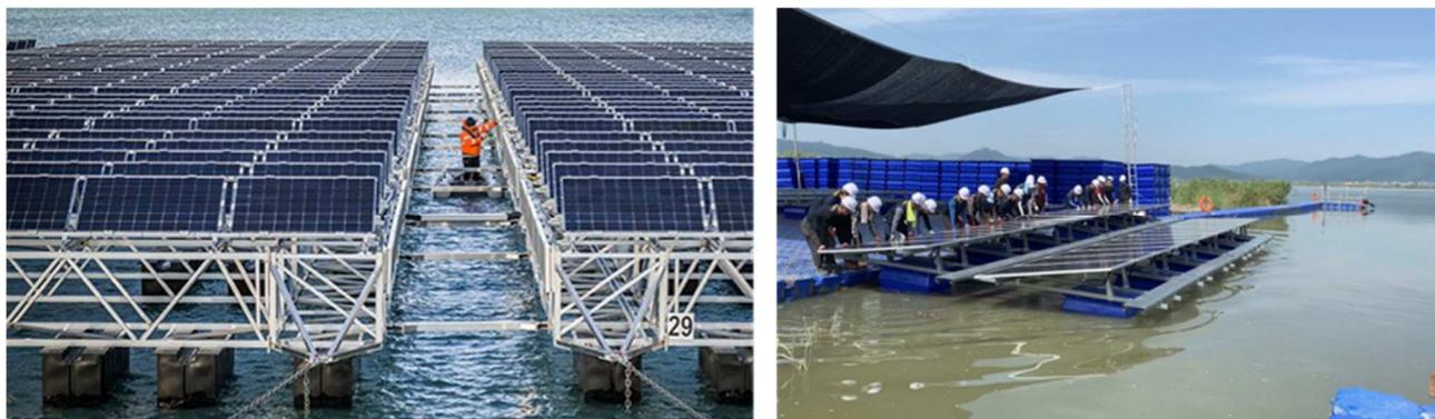
Figura 5.5 – Fotovoltaico galleggiante con struttura di supporto in acciaio.
