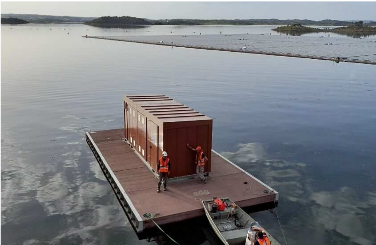
Figura 5.2 – Esempio di modulo di trasformazione compatto per parchi fotovoltaici offshore.
