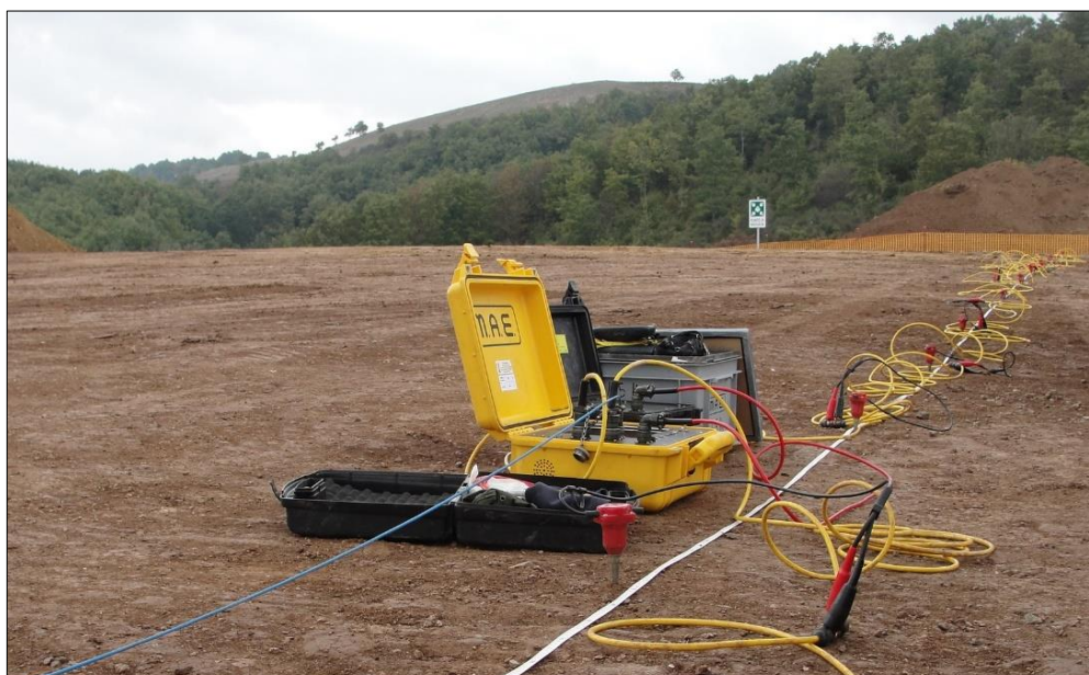
Figura 4 - Indagine sismica - Down Hole
