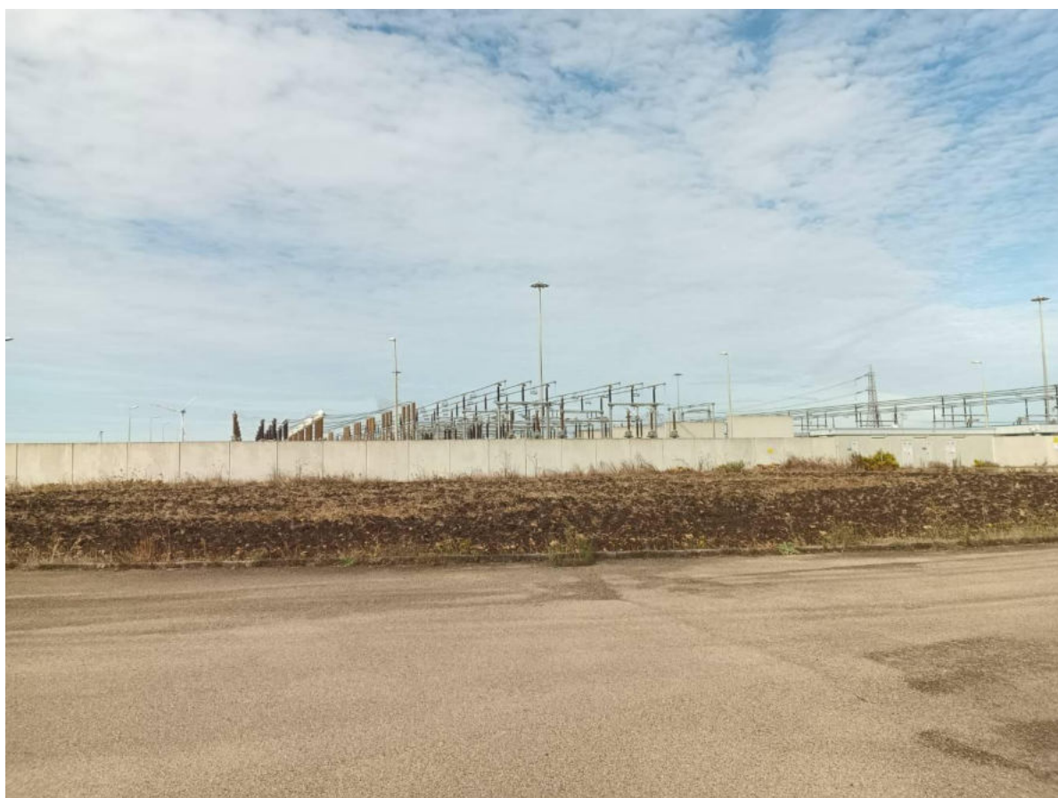
Figg. 50-63. Foto di alcuni tratti delle strade su cui sarà realizzato il cavidotto di connessione e della stazione di consegna
