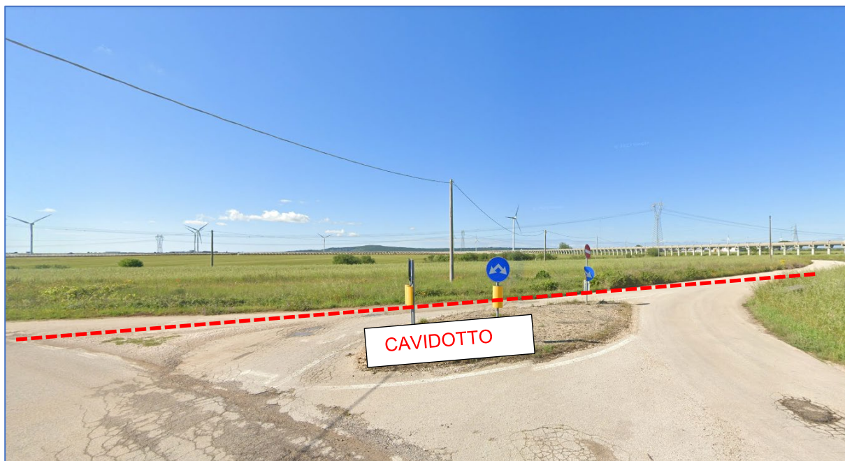
Figura 9 - Attraversamento dell'area di rispetto del Regio Tratturello alle Murge
