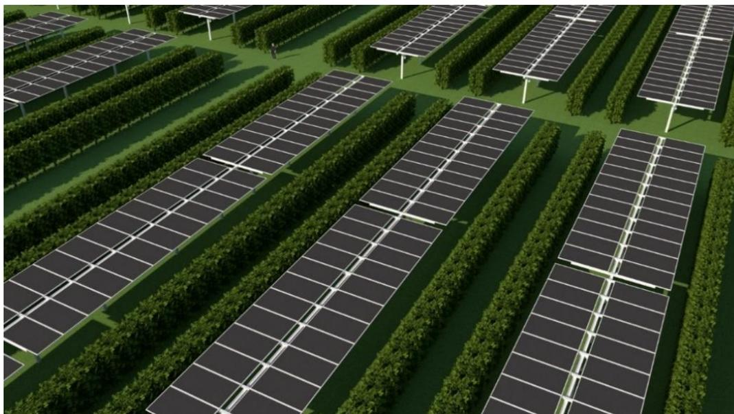
*Figura 106 - Particolare del modello, siepi ulivicole e tracker in posizione orizzontale*
