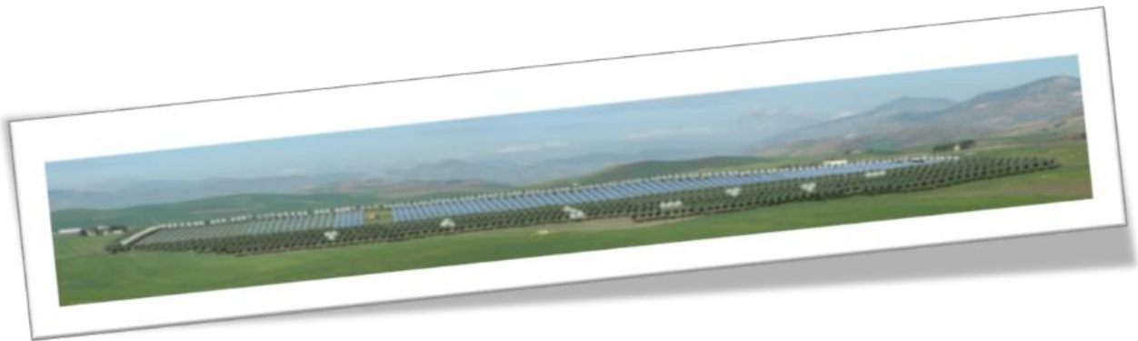
Figura 28 - Impianto fotovoltaico da 5 MW, "Heliospower", Monreale /(PA) 2010
