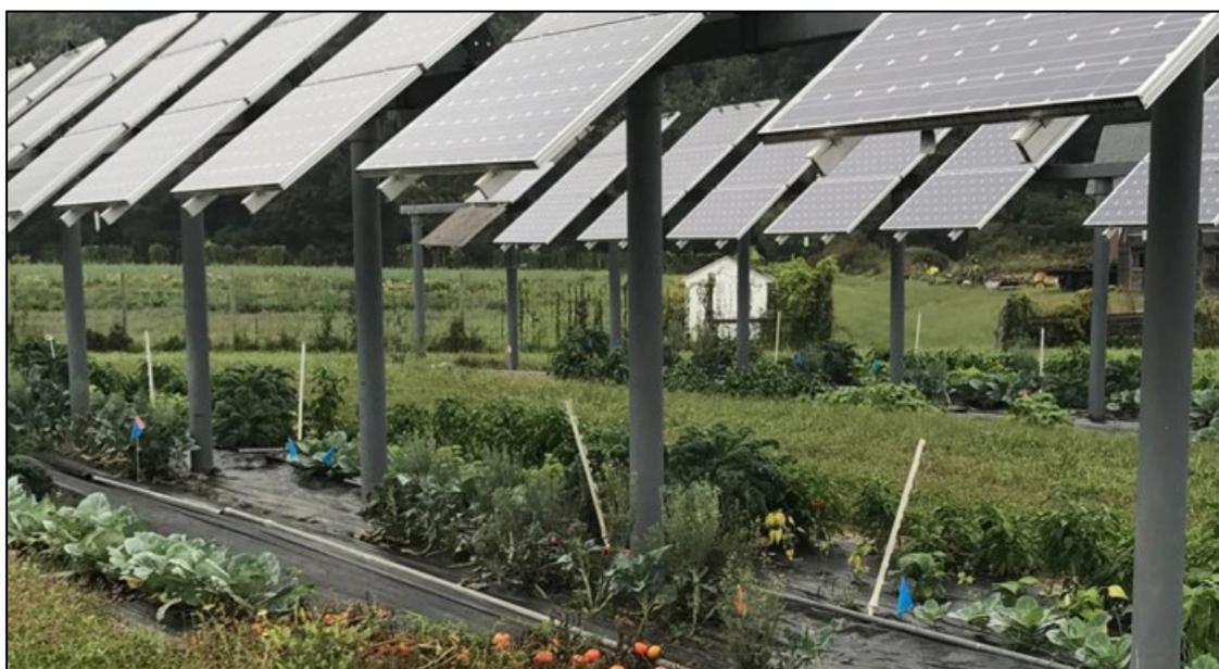
**Figura 6.2. Agrivoltaico a moduli fissi con struttura a falde in Cina, per la produzione di bacche di Goji**
