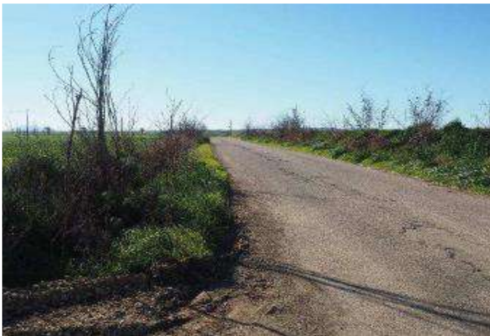
VISUALE SUD SUD OVEST
