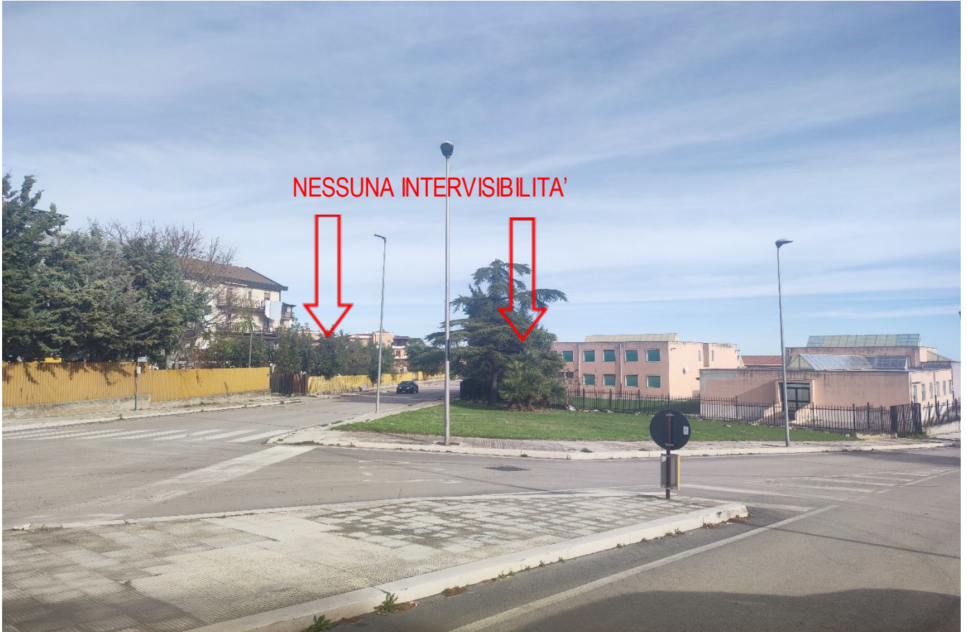
Fig. 53 Punto di presa n. 12 stato di progetto (Punto Panoramico del comune di Ascoli Satriano)
