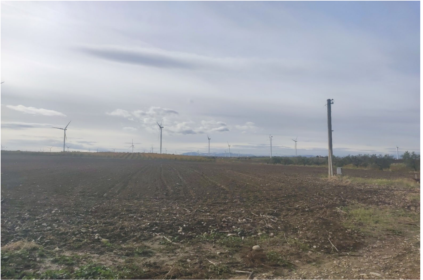
Fig. 12 Punto di presa n. 2 stato di fatto (Mass.a Durando)
