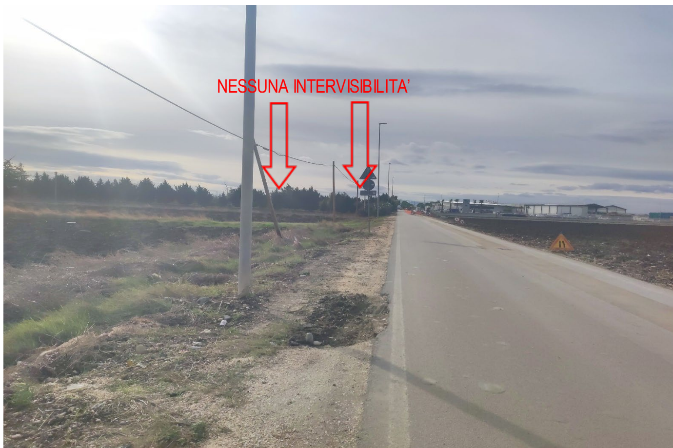
Fig. 69 Punto di presa n. 16 stato di progetto (Punto Panoramico del comune di Carapelle)
