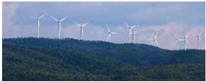
Parco Eolico Santa Luce - Provincia di Pisa
