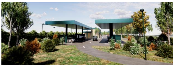
Stazione di distribuzione idrogeno
