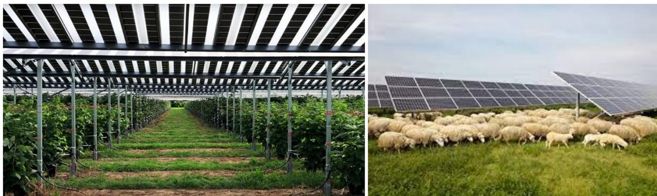
**Figura 14: Esempio di agrovoltaico (fotovoltaico con sottostante coltivazione, a sinistra, o pascolo, a destra)**
