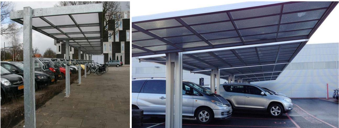
Figura 54: possibile riuso dei tracker come sostegni per pensiline con o senza pannelli solari (Fonte: immagine a sinistra: <https://www.falco.co.uk/>; immagine a destra: <https://www.canopiesuk.co.uk/>)
