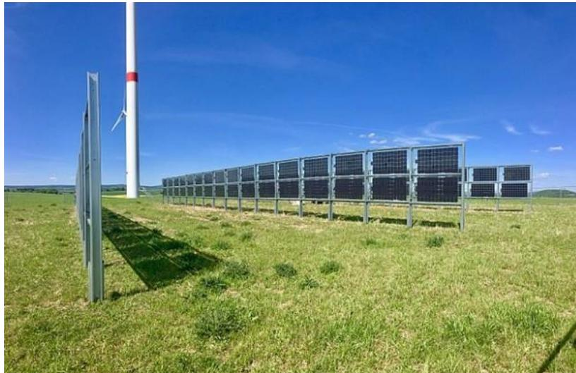
**Figura 20: Esempio di Agrovoltaco con pannelli bifacciali installati in verticale**
