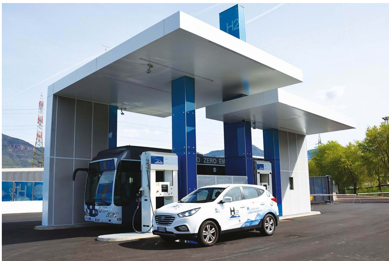
Figura 3 - Stazione di rifornimento idrogeno
