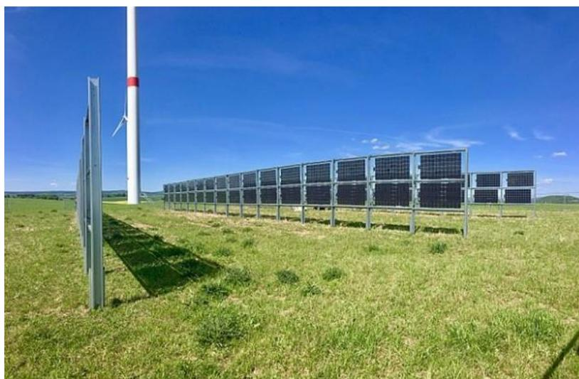
Figura 14: Esempio di Agrovoltaico con pannelli bifacciali installati in verticale
