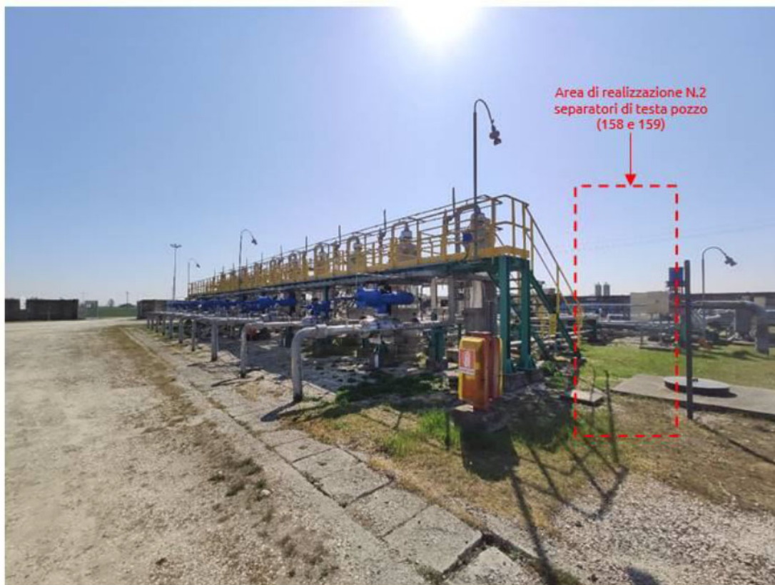
Figura 2.6: Vista dei separatori esistenti con indicazione dell'area per i nuovi separatori
