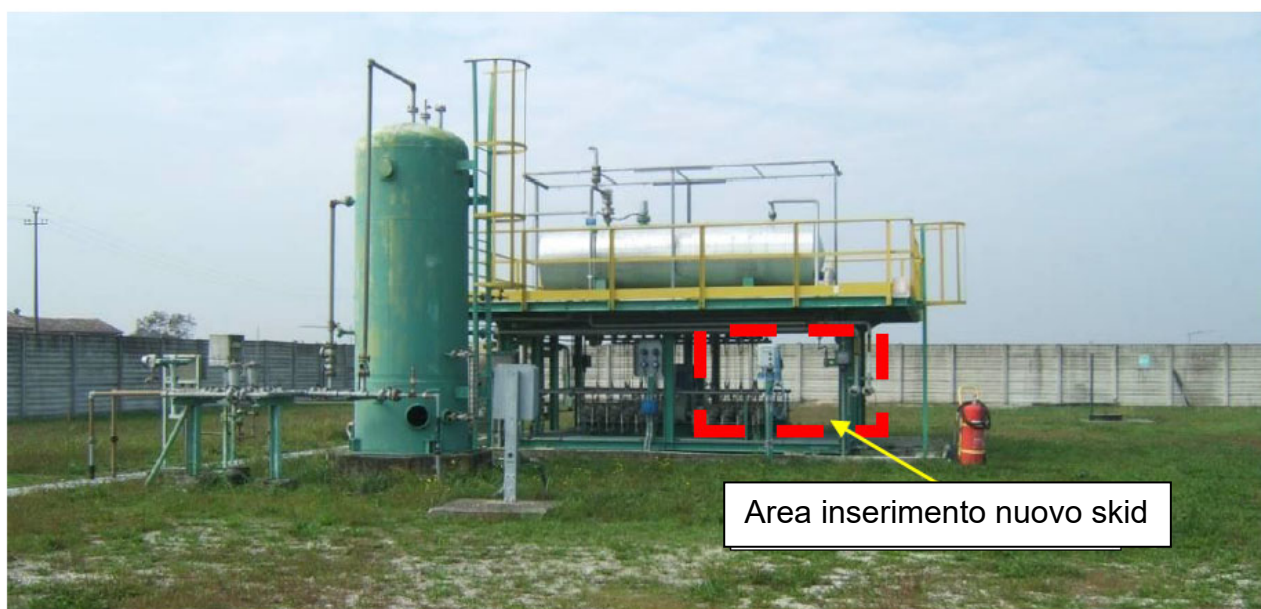
Figura 2.7: Vista Area Metanolo dove verrà installato il nuovo skid di iniezione coperto da tettoia metallica
