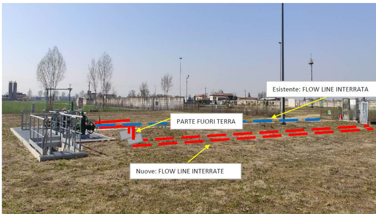
Figura 2.5: Vista esterna delle tubazioni interrato con rappresentazione delle flowlines
