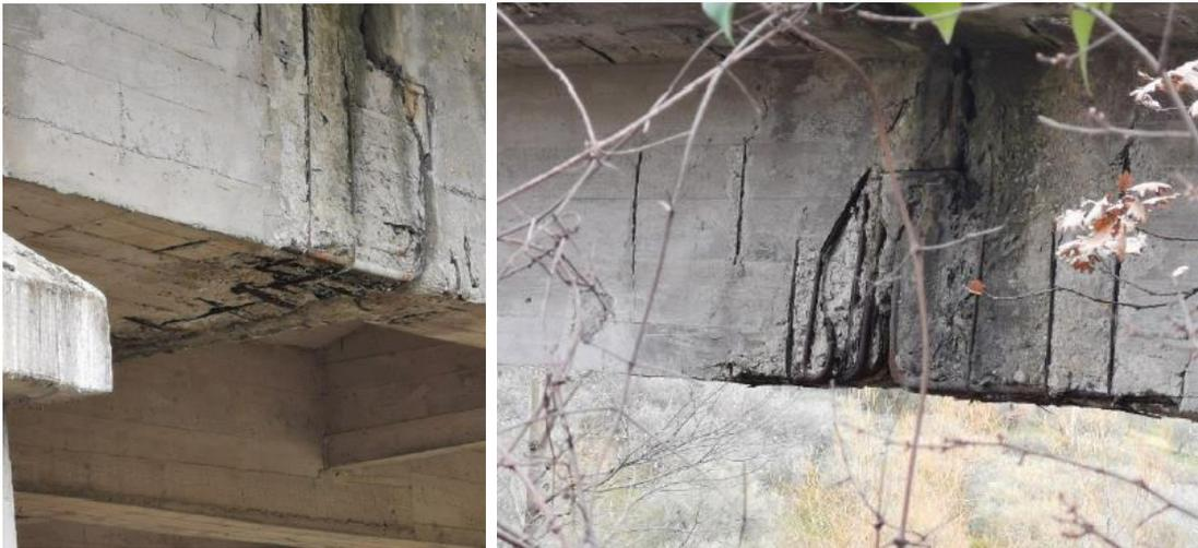
*Figura 7: Presenza di lesioni sulle mensole Gerber*
