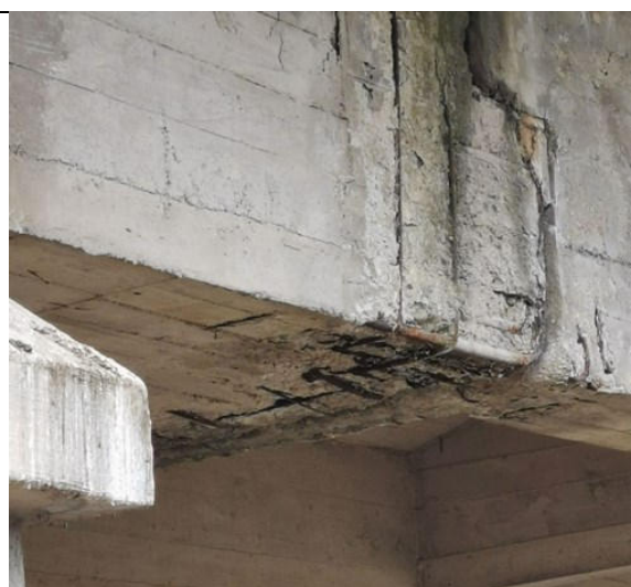
Foto 6 - Dettaglio Gerber verso pila 2 lato monte
