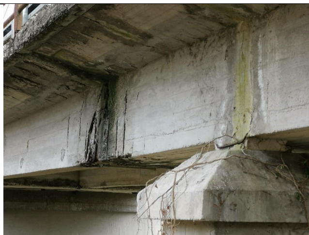
Foto 5 - Appoggio su pila 1 e seggiola Gerber lato monte
