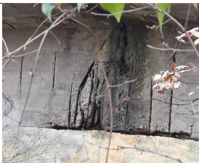
Foto 7 - Dettaglio Gerber verso pila 1 lato monte
