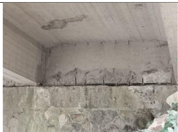
Foto 4 - Appoggio su spalla A
