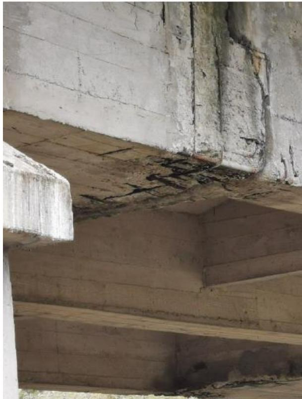
**FOTO 8. : Dettaglio Gerber verso pila 2 lato monte**
