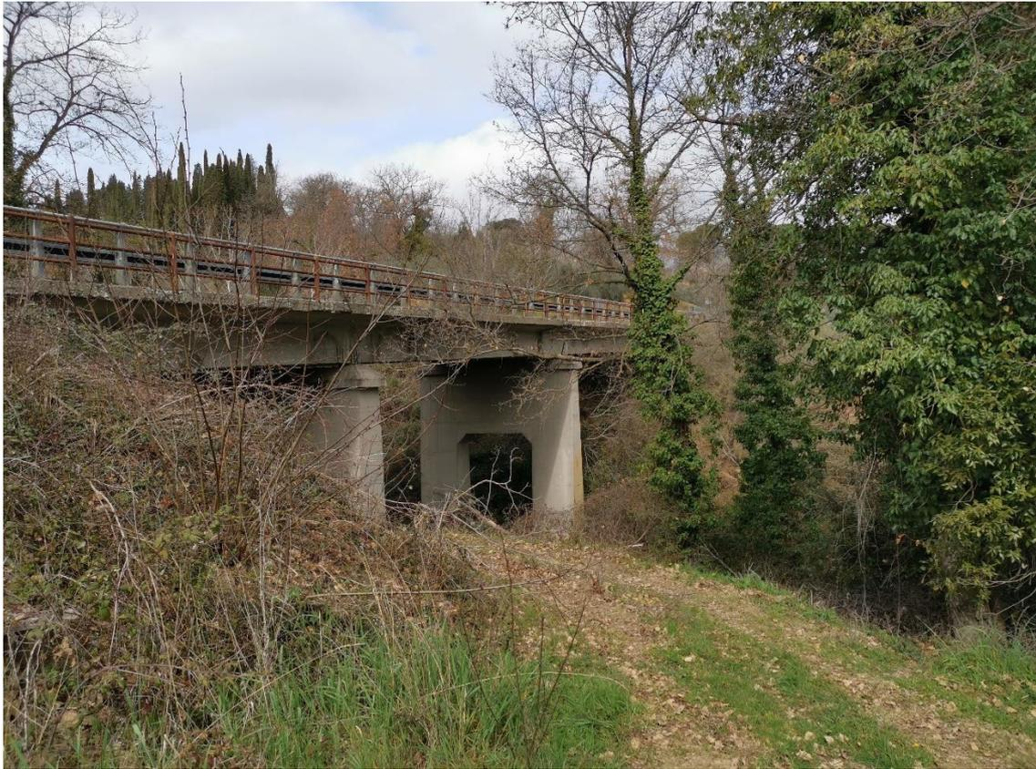
**FOTO 5. : Pile centrali e impalcato viadotto**
