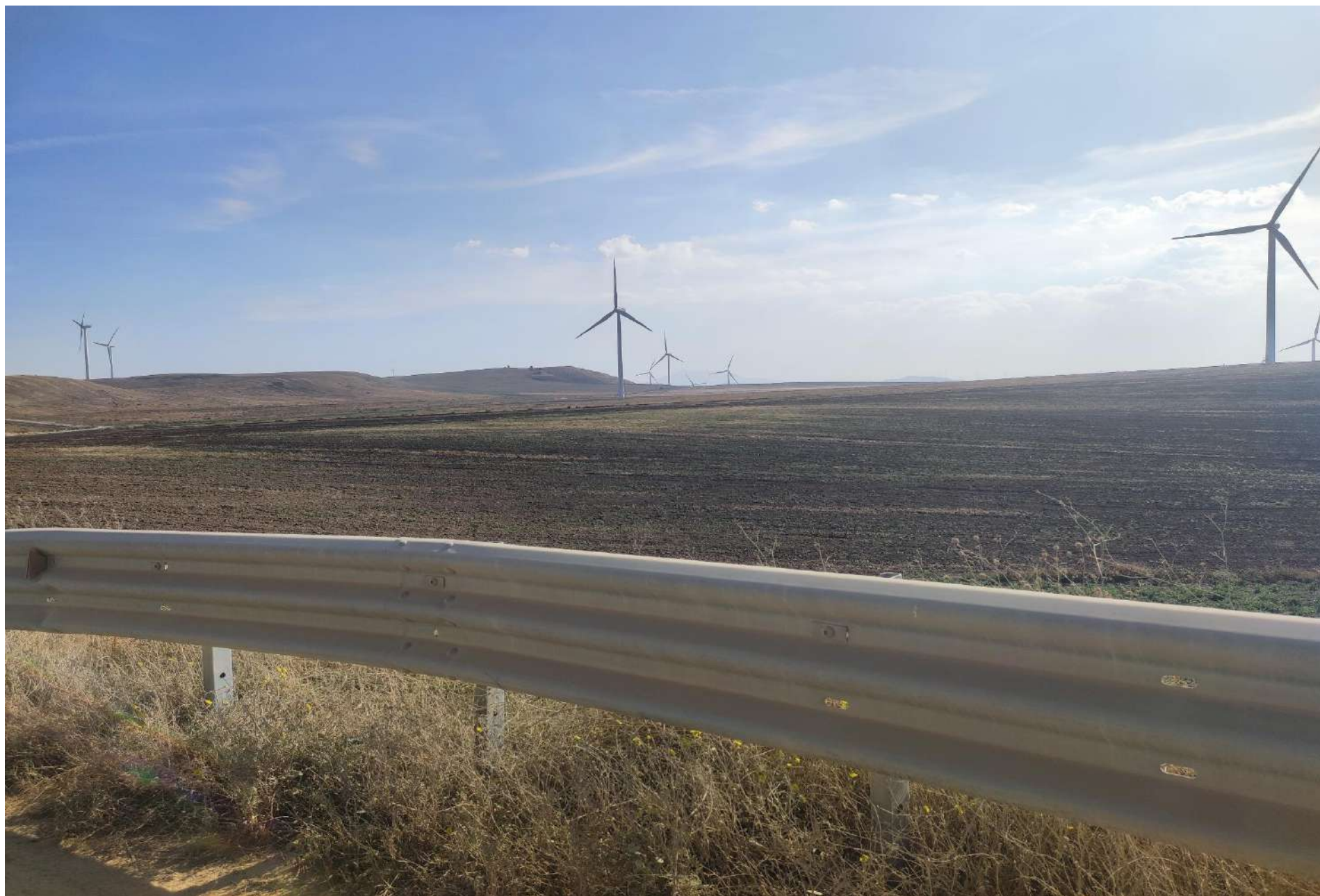
Fig. 3 Punto di presa n. 1 stato di fatto (San Donato)
