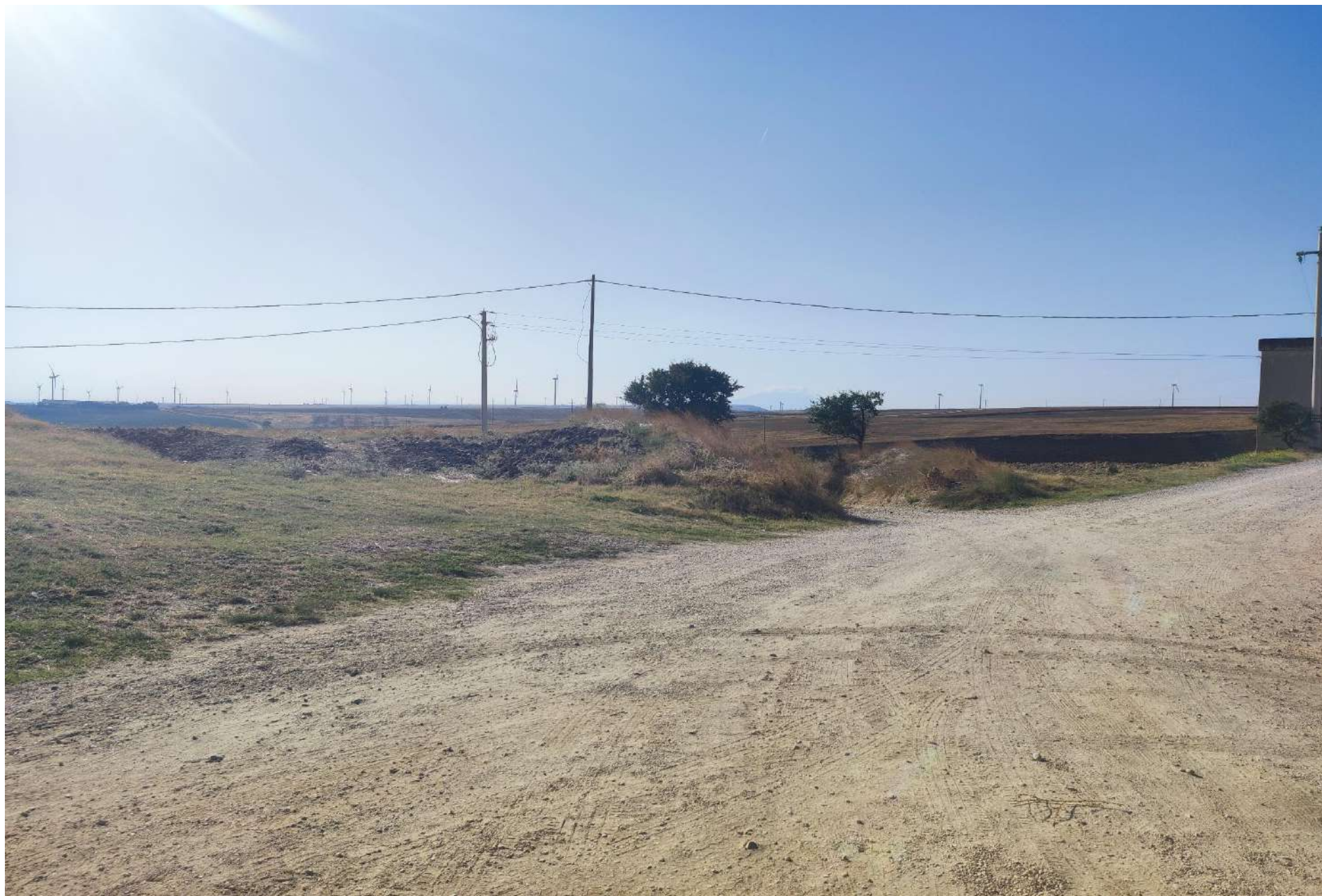
Fig. 67 Punto di presa n. 17 stato di fatto (Regio Tratturello Foggia Ascoli Lavello)
