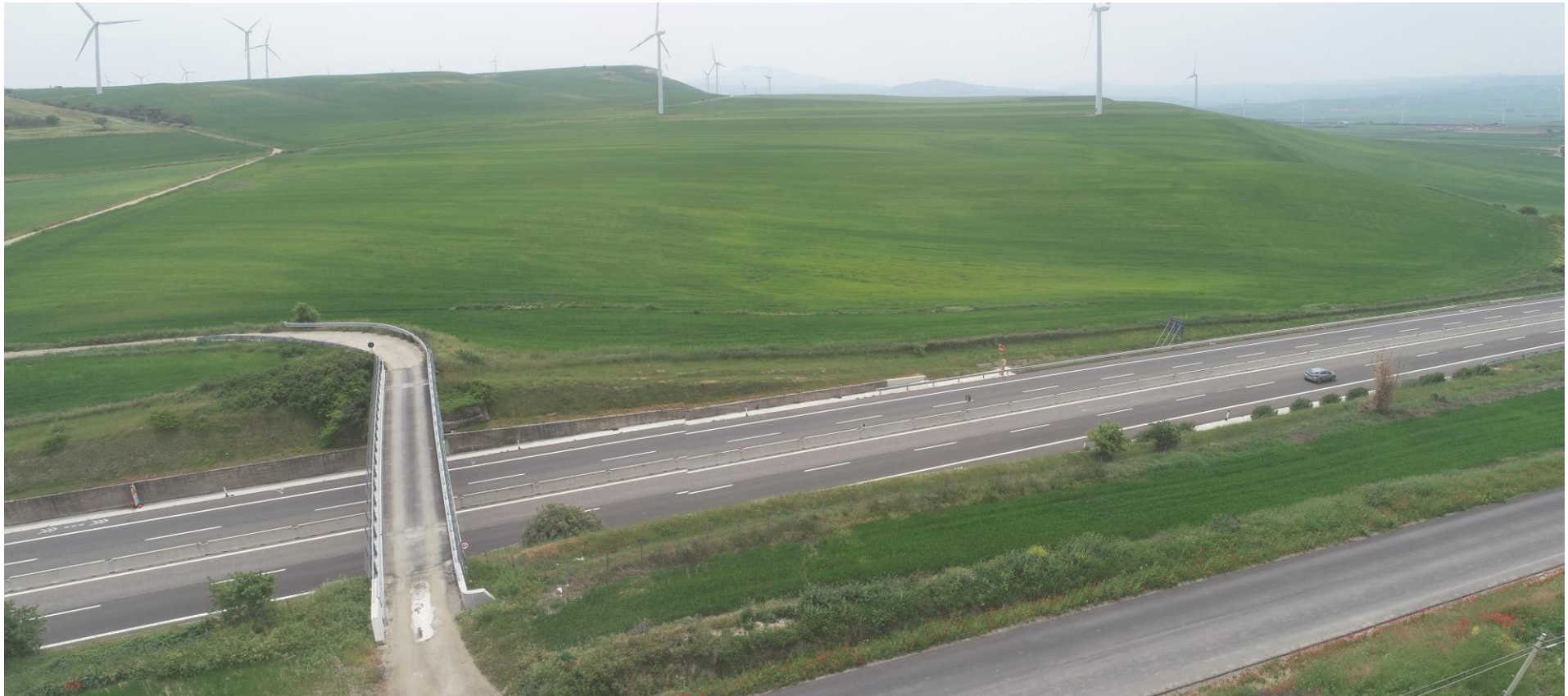
FOTO B - VISTA AEREA
