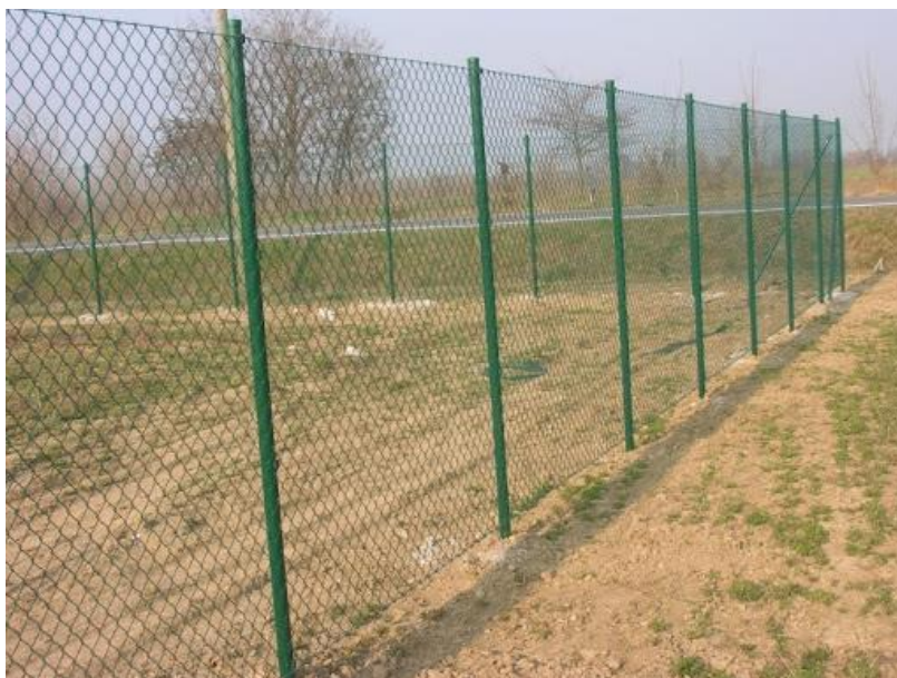
Figura 02- Esempio tipologico della recinzione perimetrale
