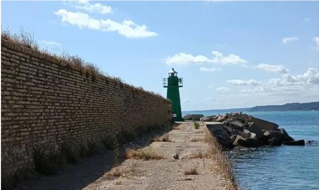
Nel tratto di testata non è presente il muro paraonde ed il fanale verde (di tipo tradizionale in forma tronco-conica) è fondato direttamente sul massiccio di coronamento
