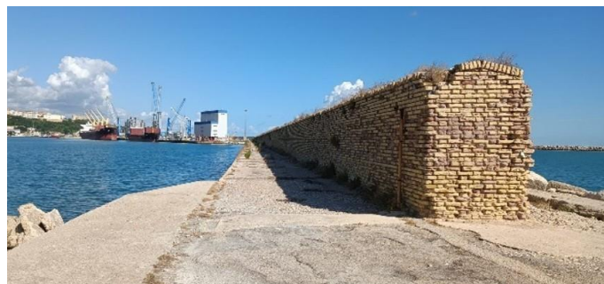
Figura 3-8 - Attuale massiccio di coronamento e muro paraonde
