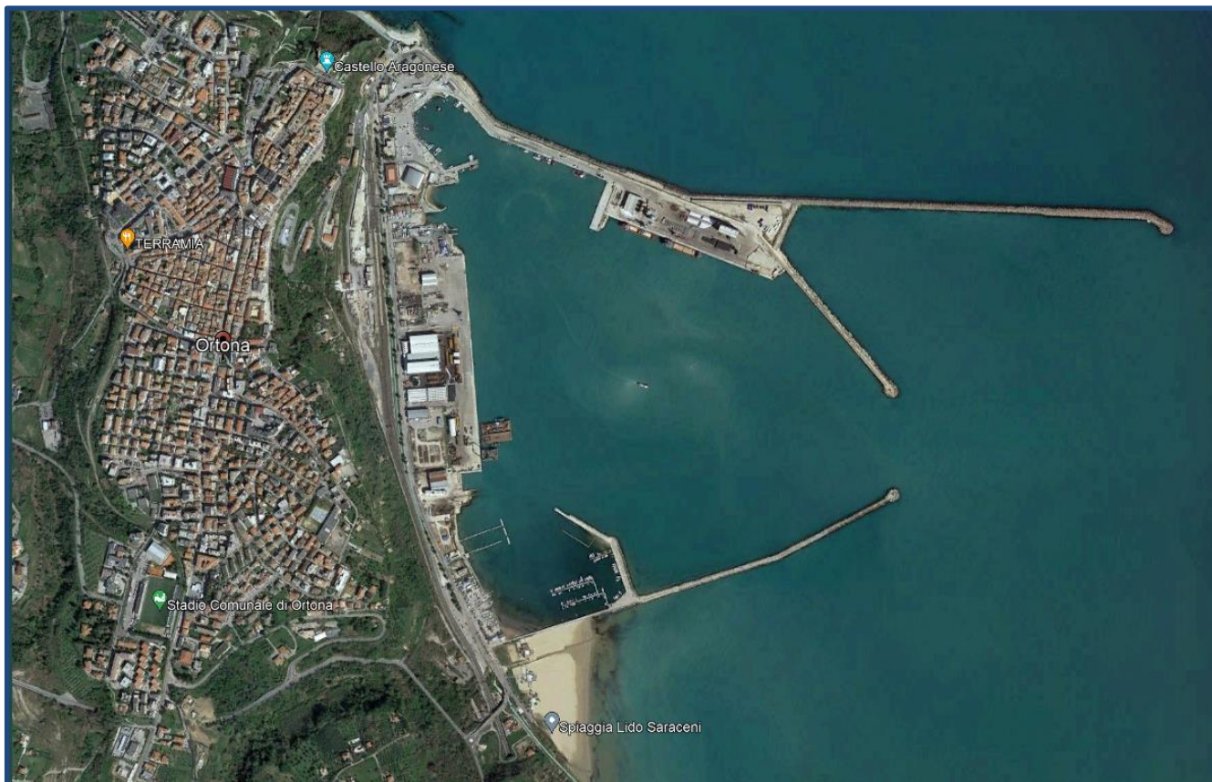
Figura 1: posizionamento geografico del porto di Ortona.
