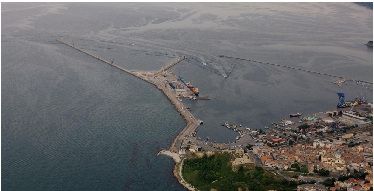
Figura 3-14. Vista aerea del porto di Ortona durante i lavori di costruzione della Nuova Diga Nord (2008-2011)
