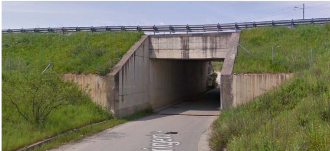
Vista imbocco Est
