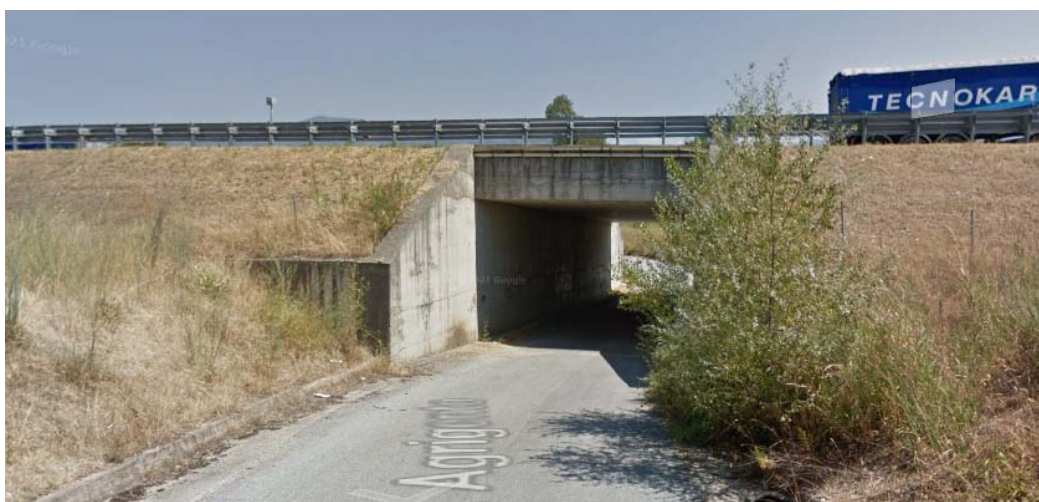
Vista imbocco Ovest
