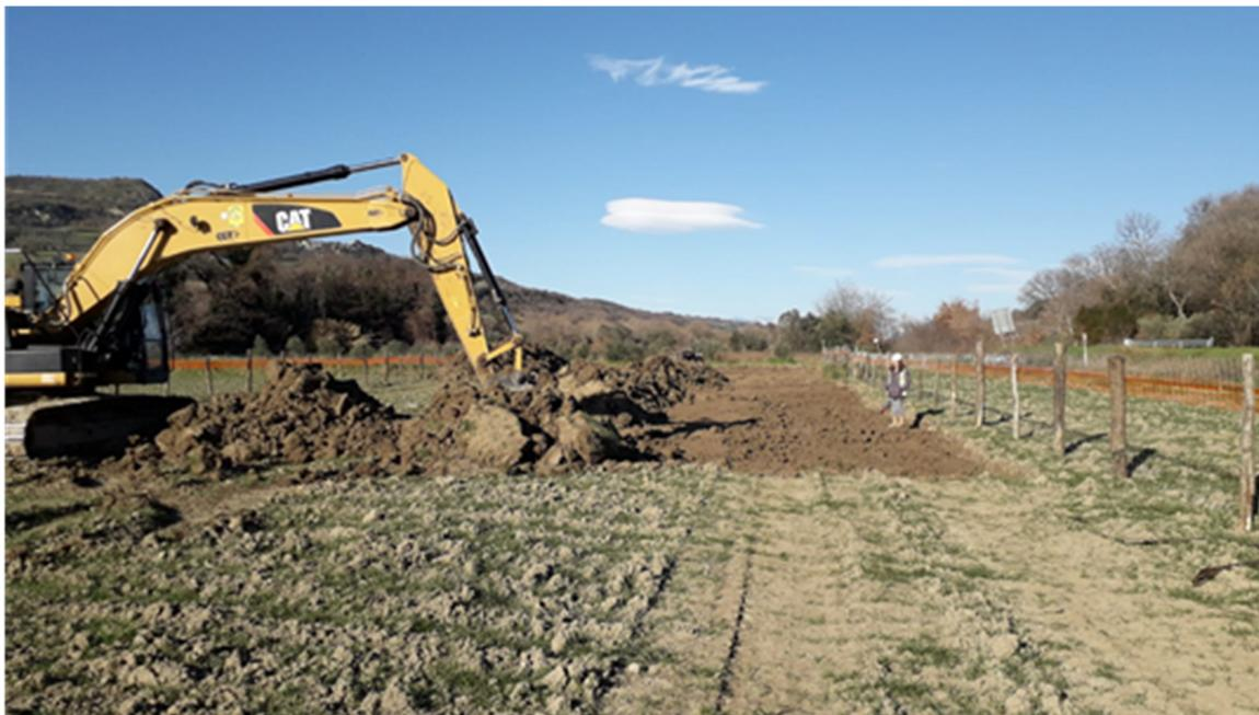
**Fig. 2.8/A: Apertura pista di lavoro con accantonamento (a sinistra) dello strato superficiale di terreno (humus)**
