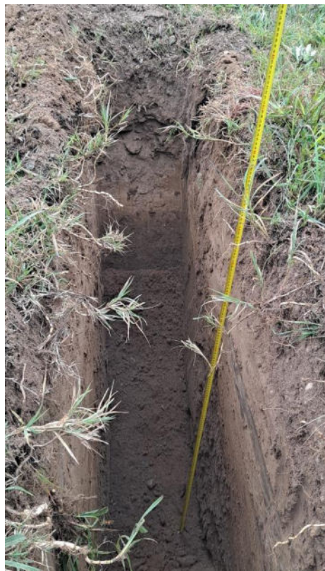
Figura 3.2 Pescavo del piezometro WTP1
