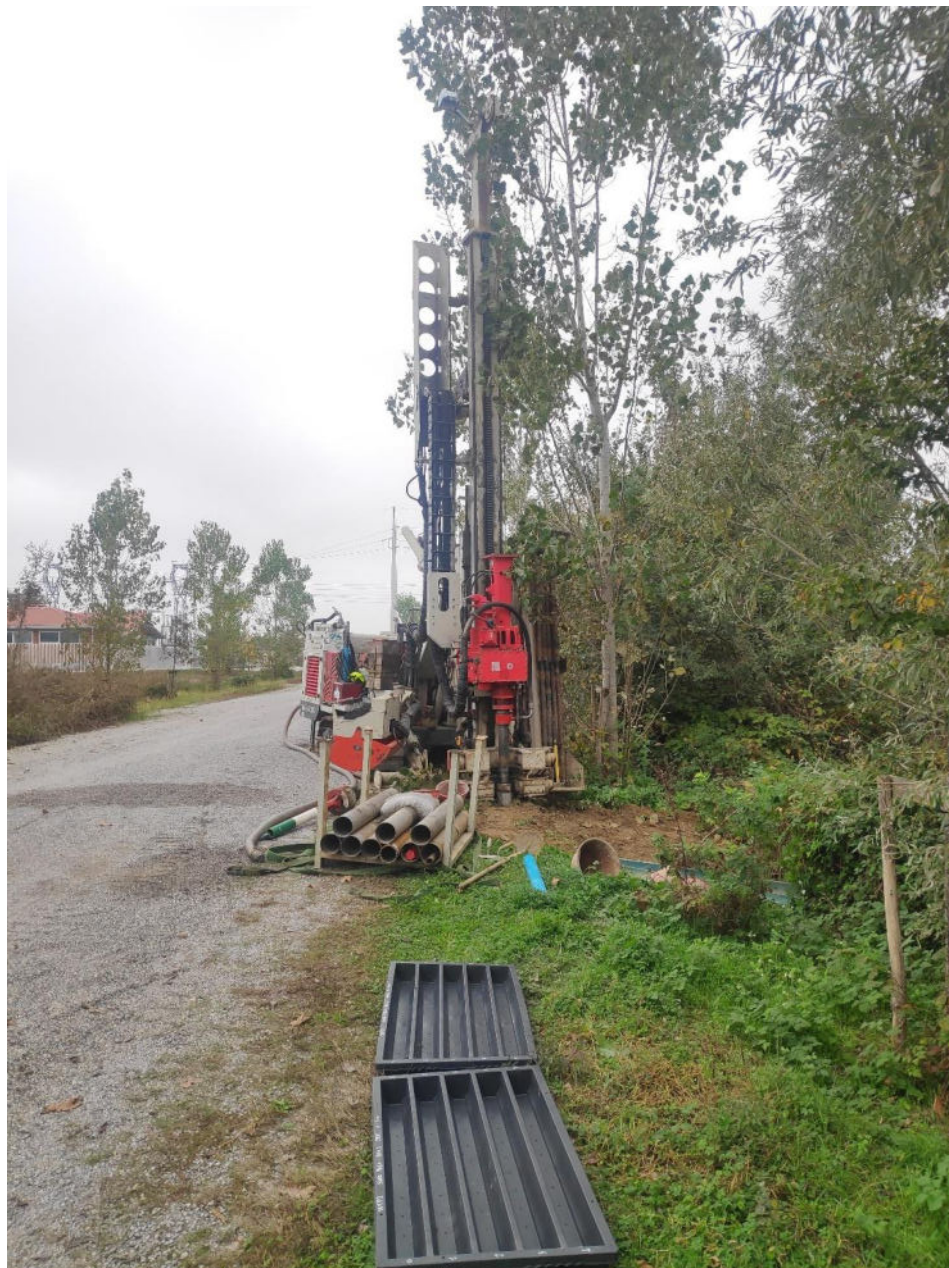
Figura 3.7 Perforazione piezometro WTP2
