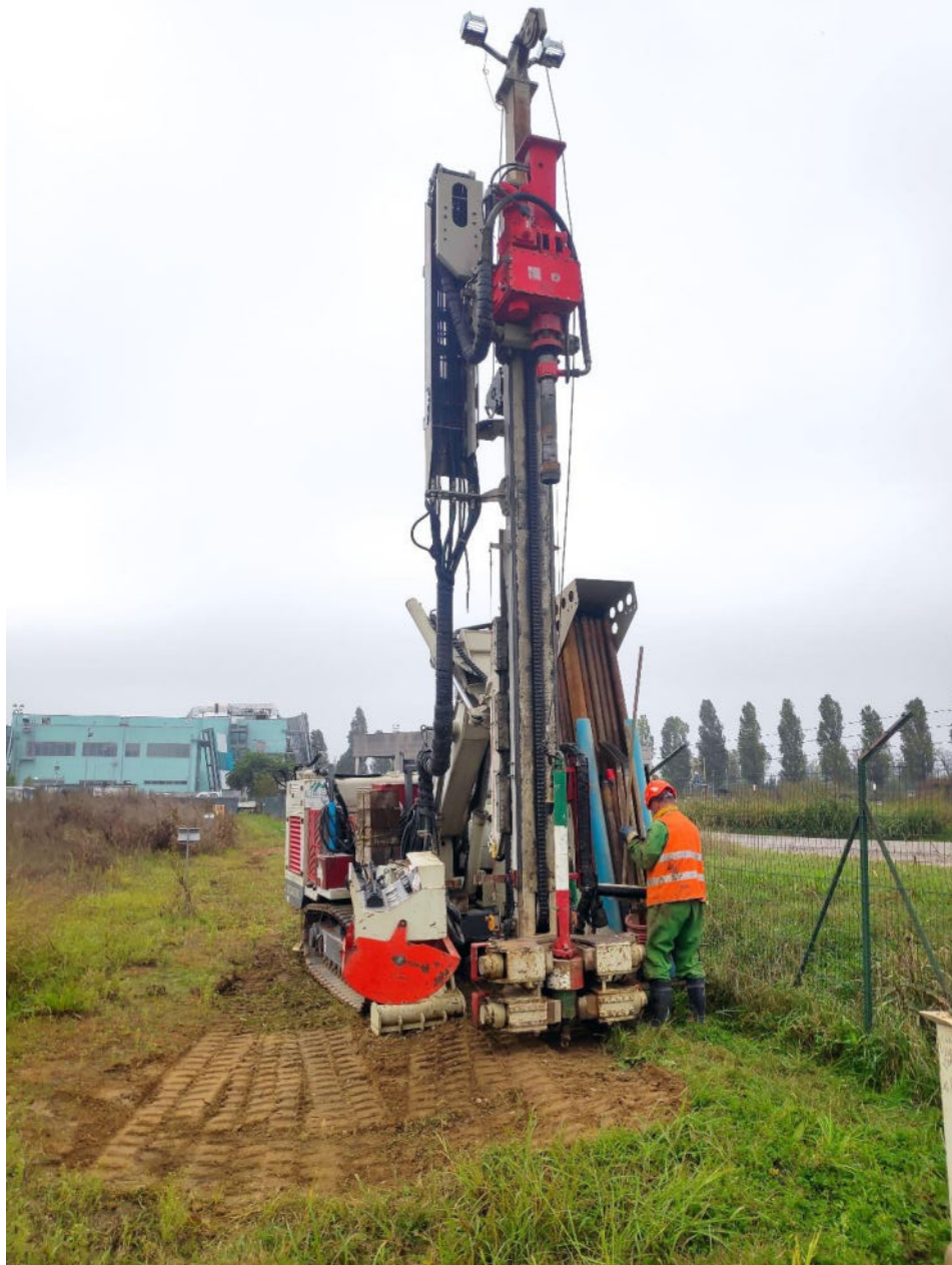
Figura 3.4 Perforazione piezometro WTP1
