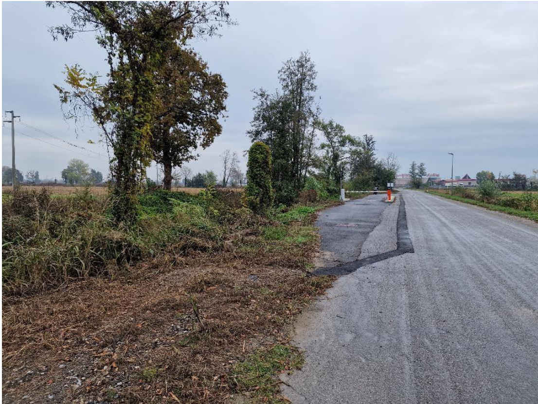
Figura 25 - la fascia da ricostituire
