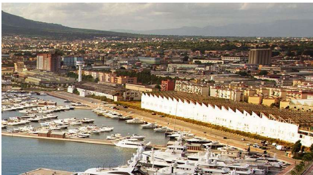
I volumi industriali oggi dismessi nelle aree di Marina di Stabia
