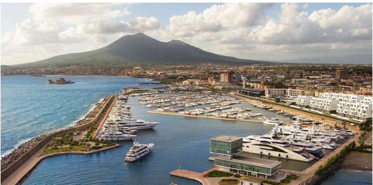
Vista tridimensionale del progetto di Variante delle opere a terra del porto di Marina di Stabia
