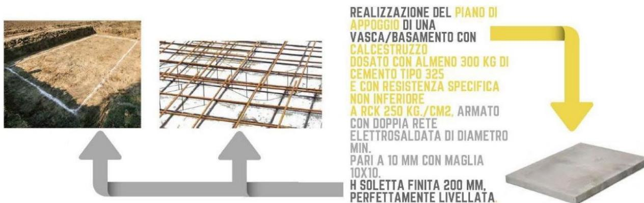
*Scavi per la realizzazione del piano di appoggio delle vasche di fondazione delle cabine*
