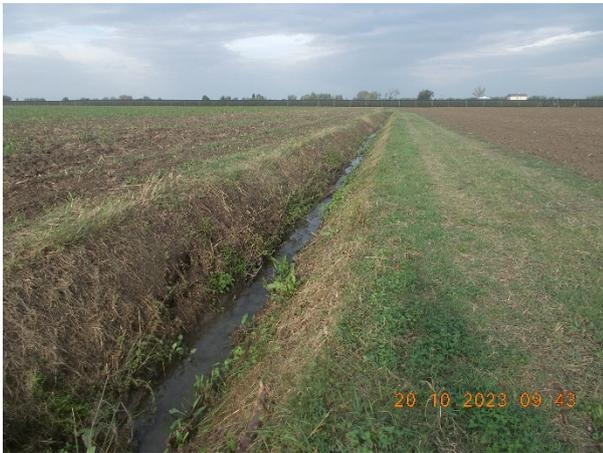
Foto del fosso di drenaggio, sottoposto a pulitura delle erbe al fine di agevolare il deflusso delle acque meteoriche superficiali dei terreni
