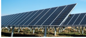
Impianto sub-verticale fisso con inclinazione 35°
