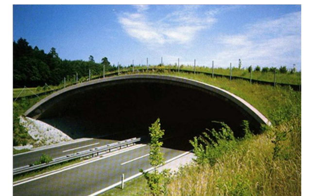
Esempio galleria artificiale in ambito agricolo
