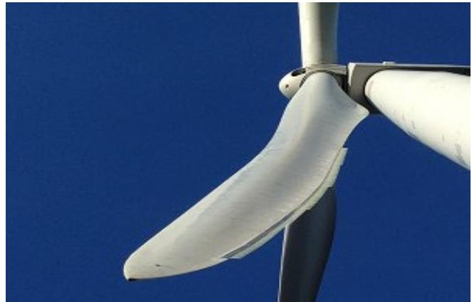
Ciascuna pala è dotata, di un sistema di protezione antifulmine, munito di ricettore che convoglia l'energia verso il circuito di messa a terra della macchina al fine di salvaguardare la sicurezza e lo stato delle apparecchiature.
