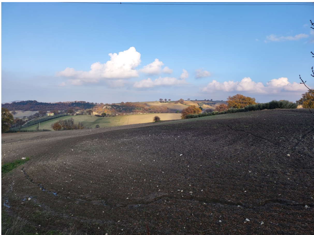
Palata (CB). Loc. Colle di Lepore. Area del sostegno dell'elettrodotto 168 N
