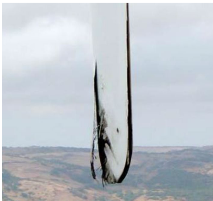
Figura 1 - Estremità della pala danneggiata da fulminazione atmosferica
