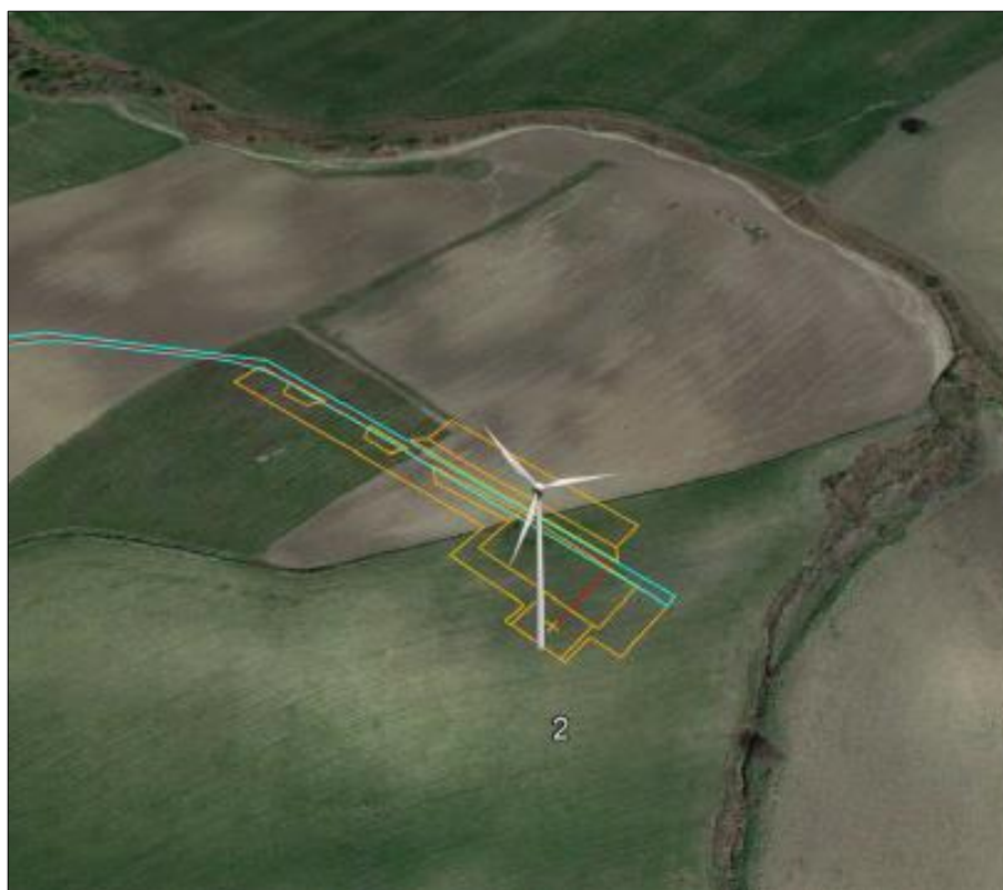
Figura 4 - Sito di installazione WTG 02
