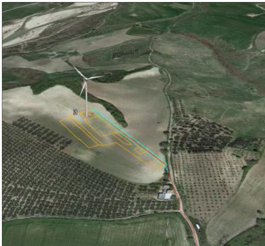
Figura 5 - Sito di installazione WTG 03
