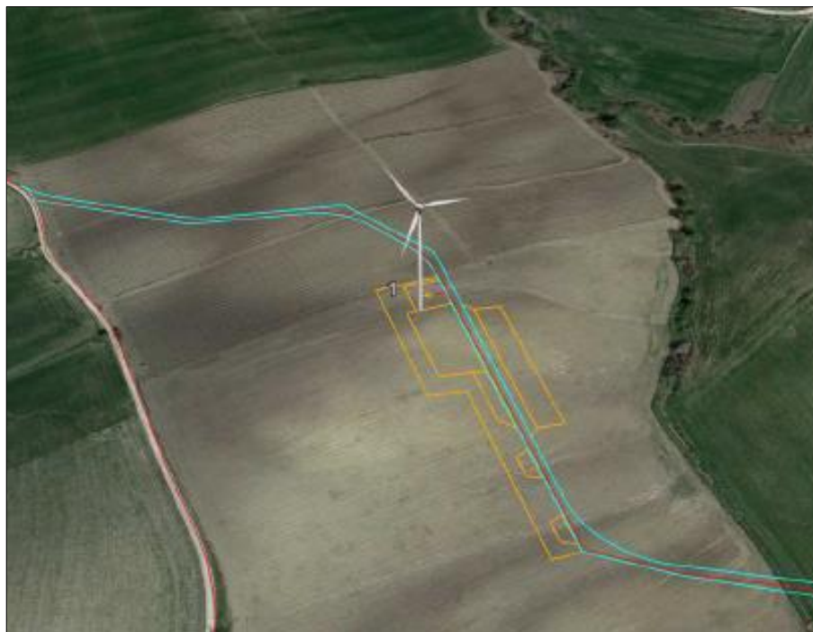
Figura 3 - Sito di installazione WTG 01
