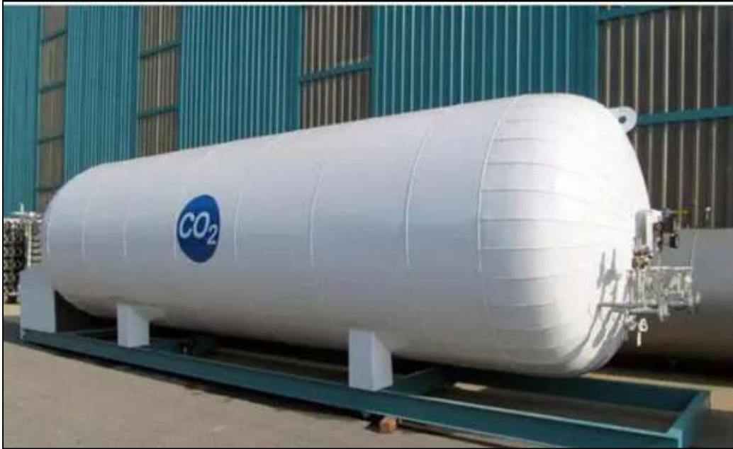
FIGURA 5-32: STOCCAGGIO CRIOGENICO DELLA CO 2 (VOLUME 50 M 3 )
