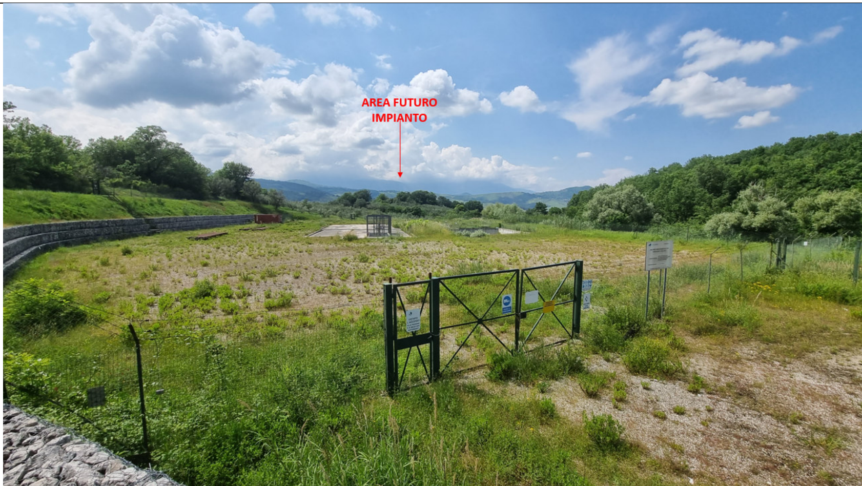
Foto No.2: Installazioni Area pozzo MP1-2
